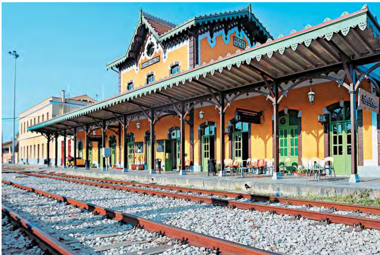
Εικόνα 27: Σιδηροδρομικός σταθμός Βόλου
