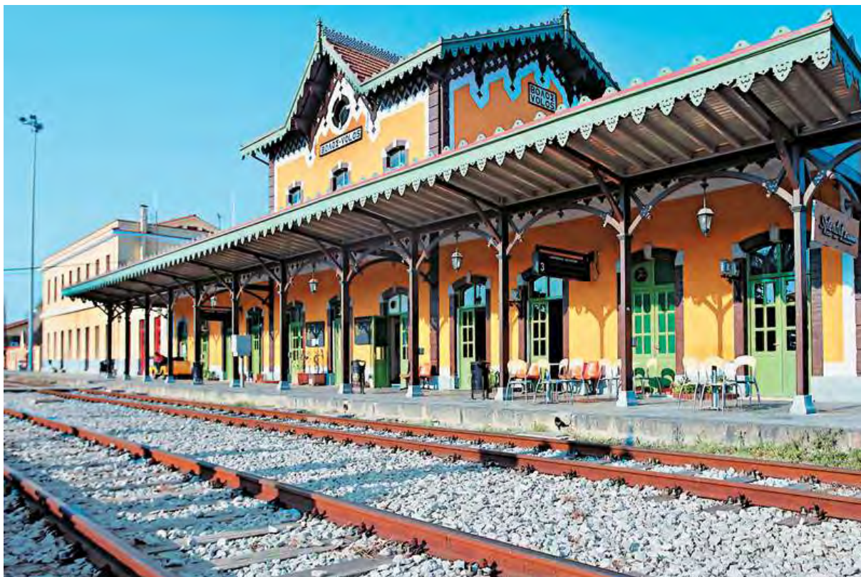
Εικόνα 27: Σιδηροδρομικός σταθμός Βόλου
