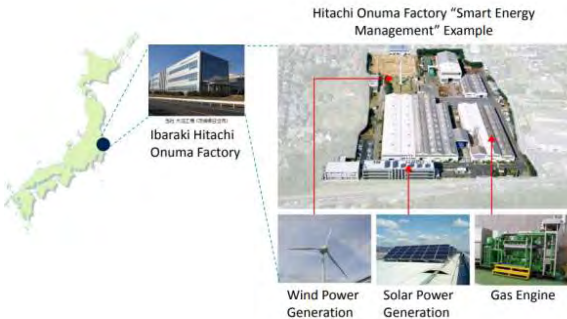
Εικόνα 46: Η βιομηχανική περιοχή 'Ibaraki Hitachi' στην Ιαπωνία (1)
