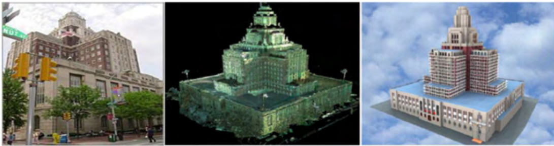
Εικόνα 50. Υπηρεσία GSA, ΗΠΑ. Η χρήση του 3D λέιζερ παρείχε πληροφορίες για το «πραγματικό» και το ψηφιακό μοντέλο, αντίστοιχα. Αριστερά: Το πραγματικό κτήριο. Κέντρο: καταγραφή 3D λέιζερ. Δεξιά: μοντέλο BIM (Παναγιωτίδου, 2016).
