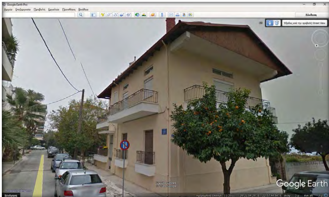
Εικόνα 43. Προοπτική άποψη κτηρίου περιοχής μελέτης (Street View, Google Earth Pro, 2018).
