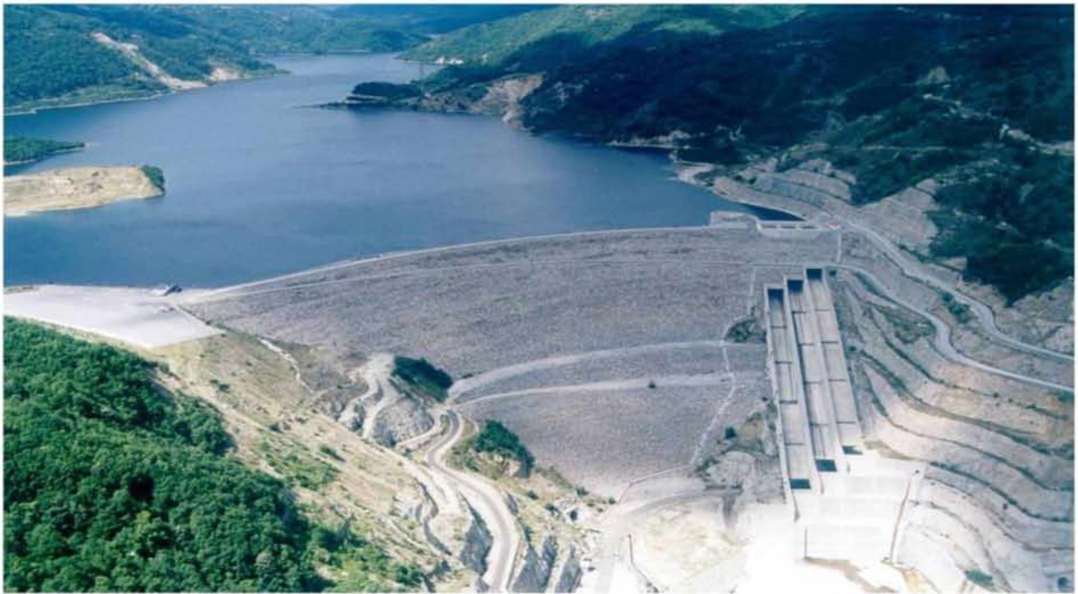
Εικόνα 2.2.4.2.1. Χωμάτινο φράγμα Θησαυρού, Δράμα [36].
