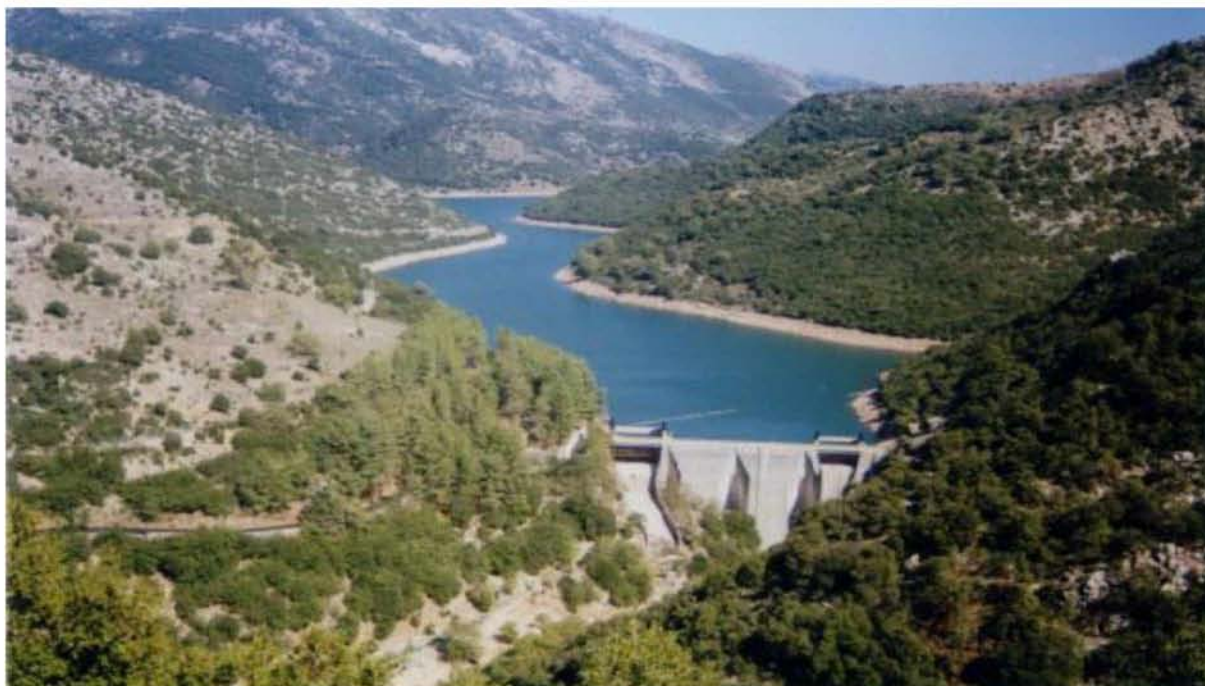
Εικόνα 2.2.4.1.3. Αντηριδωτό φράγμα Λάδωνα, Αρκαδία [35].
