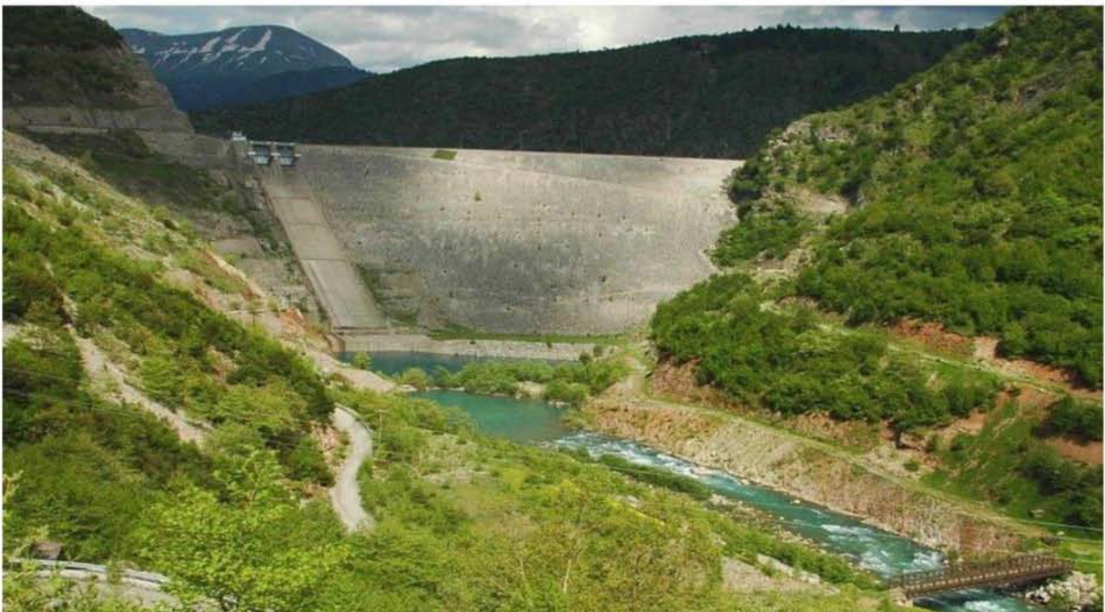
Εικόνα 2.2.4.2.2. Λιθόρριπτο φράγμα με ανάντη πλάκα σκυροδέματος, Μεσοχώρα, Τρίκαλα [10].
