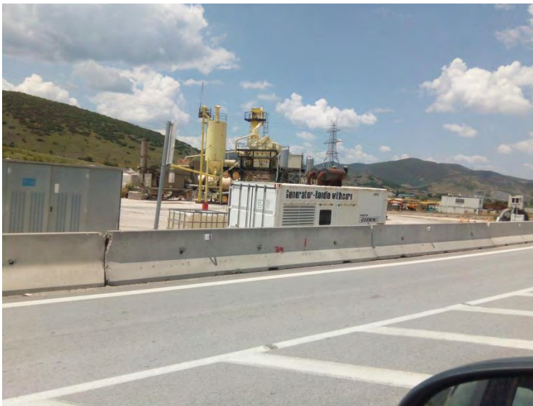
Εικόνα 17: Δανειοθάλαμοι απόληξης υλικών και εργοτάξιο κοντά στην Ξυνιάδα
