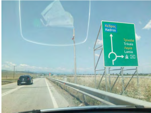
Εικόνα 25: Διασταύρωση για Κέδρο
