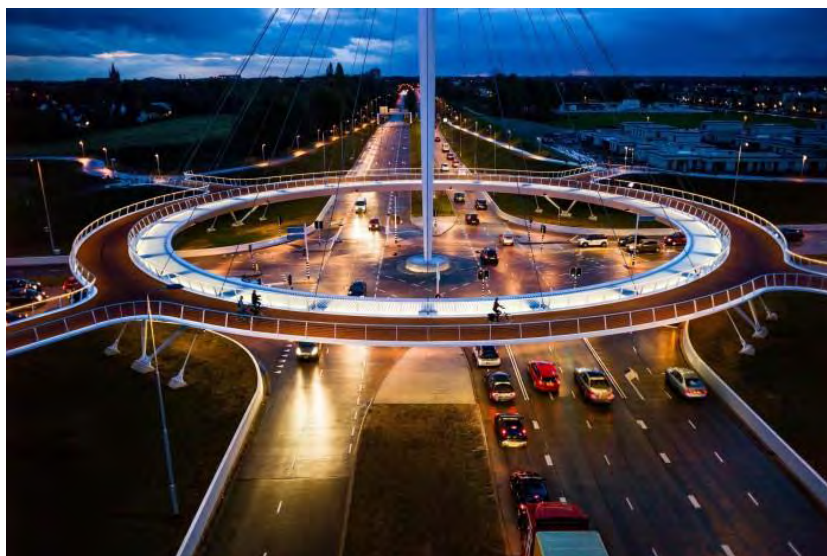
Εικόνα 2.7: Ανισόπεδος κυκλικός κόμβος στο Αϊντχόφεν (investinholland.com, 2017)
