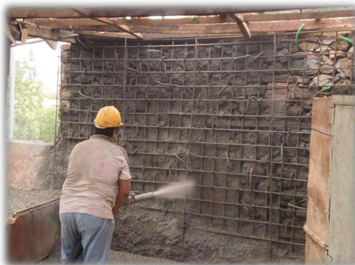
Σχήμα 2- 11:Χρήση εκτοξευόμενου σκυροδέματος (Βαρδακαστάνης, Δομικοί έλεγχοι)
