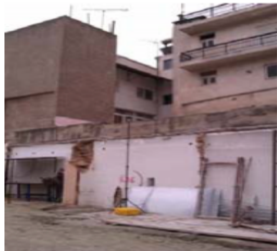
ΕΙΚΟΝΑ 22 Εργοτάξιο «ΜΑΝΙΑΤΙΚΑ»- ΑΥΤΟΝΟΜΟΣ ΚΙΝΗΤΟΣ ΣΤΑΘΜΟΣ ΘΟΡΥΒΟΥ ΜΕ ΣΤΑΤΙΣΤΙΚΟ ΑΝΑΛΥΤΗ ΚΑΙ ΔΙΑΤΑΞΗ ΠΑΝΤΟΣ ΚΑΙΡΟΥ (ΣΕ ΕΙΔΙΚΟ ΙΣΤΟ) ΤΥΠΟΥ
