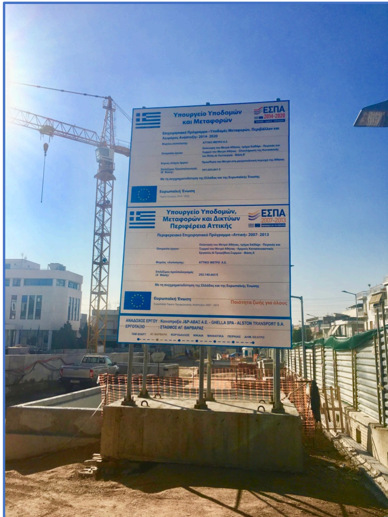
ΕΙΚΟΝΑ 16 Εργοτάξιο «ΑΓ. ΒΑΡΒΑΡΑ»- ΑΥΤΟΝΟΜΟΣ ΚΙΝΗΤΟΣ ΣΤΑΘΜΟΣ ΘΟΥΡΒΟΥ
