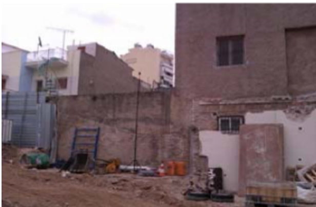
ΕΙΚΟΝΑ 22 Εργοτάξιο «ΜΑΝΙΑΤΙΚΑ»- ΑΥΤΟΝΟΜΟΣ ΚΙΝΗΤΟΣ ΣΤΑΘΜΟΣ ΘΟΡΥΒΟΥ ΜΕ ΣΤΑΤΙΣΤΙΚΟ ΑΝΑΛΥΤΗ ΚΑΙ ΔΙΑΤΑΞΗ ΠΑΝΤΟΣ ΚΑΙΡΟΥ (ΣΕ ΕΙΔΙΚΟ ΙΣΤΟ) ΤΥΠΟΥ
