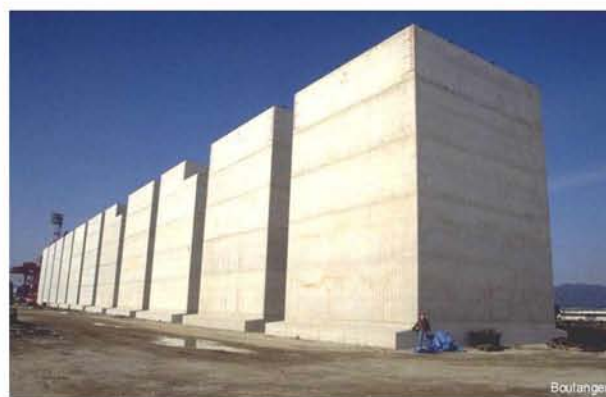
Εικόνα 2.2.1 Κρηπιδότοιχος από κυψελωτά κιβώτια στη φάση της κατασκευής [πηγή: https://research.engineering.ucdavis.edu ]
