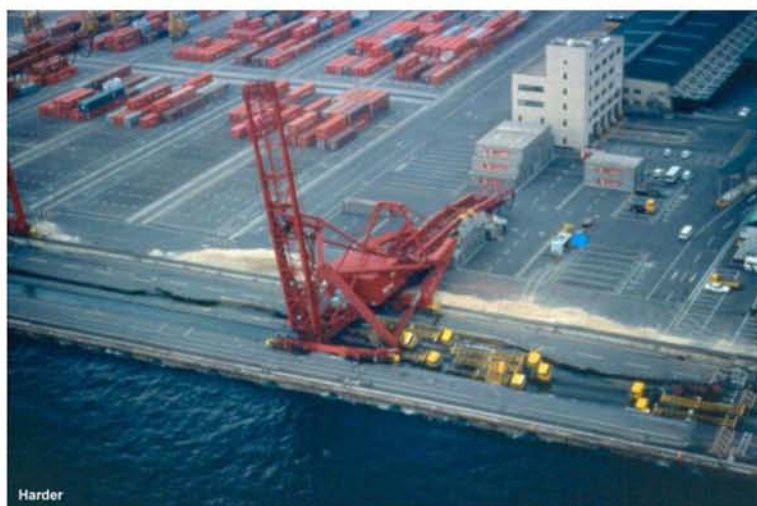
Εικόνα 3.2 Κατάρρευση γερανού στο νησί Rokko [πηγή: https://research.engineering.ucdavis.edu ]
