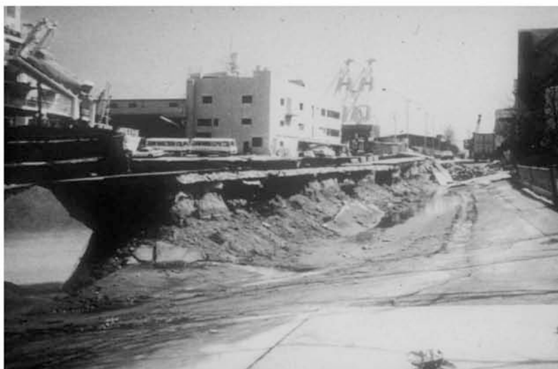
Εικόνα 3.3 Σημαντική παραμόρφωση πίσω από κρηπιδότοιχο στο λιμάνι του Κόμπε [πηγή: Towhata et al. 2009]
