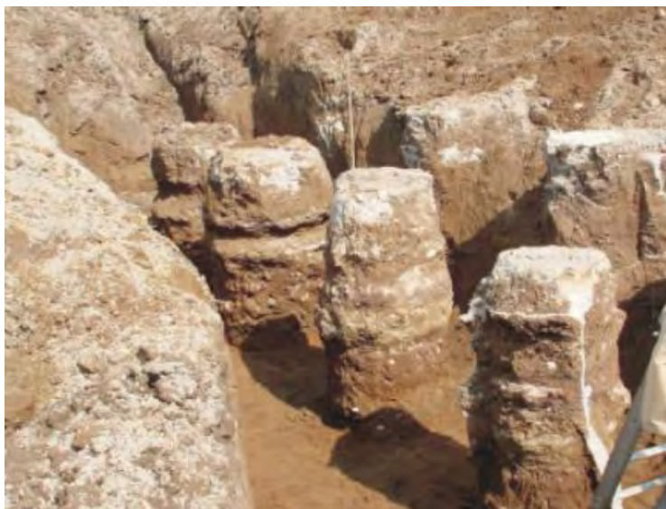
Σχήμα 4.6: Επιτόπου δοκιμές εδαφοπασσάλων
