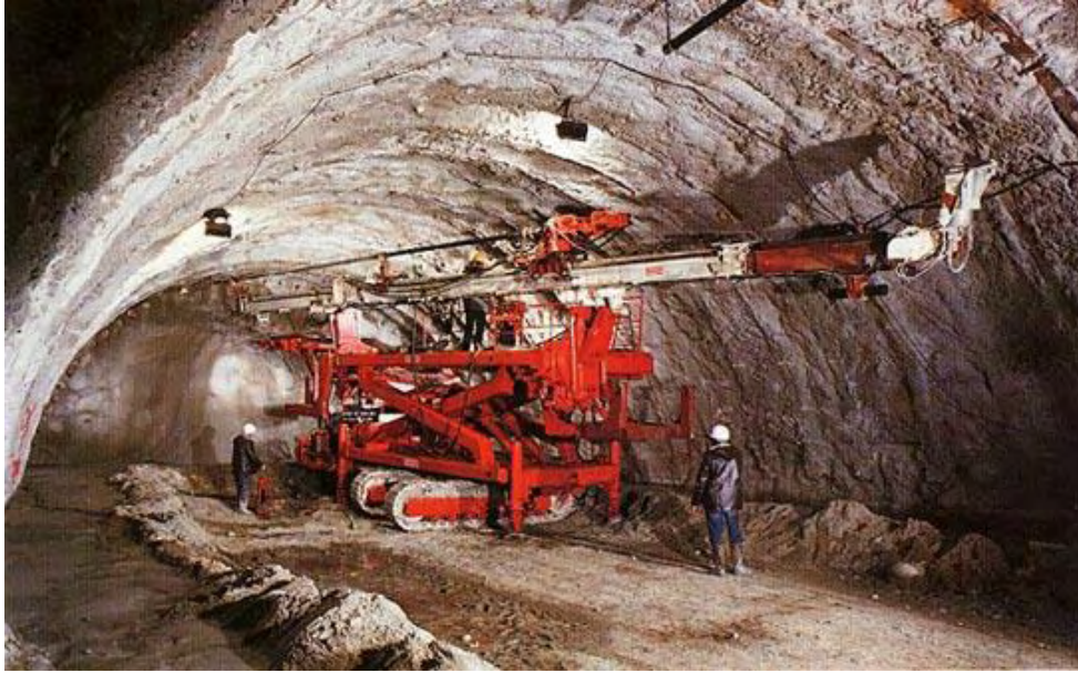
Σχήμα 3.17: Ενίσχυση των εσωτερικών τοιχωμάτων της σήραγγας
