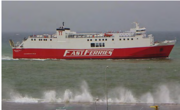
Εικόνα 1 Ανεπαρκή εξωτερικά λιμενικά έργα. Λιμένας Ραφήνας.
