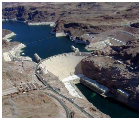
Εικόνα 1.2 Φράγμα Βαρύτητας, Hoover, Αριζόνα [2].
