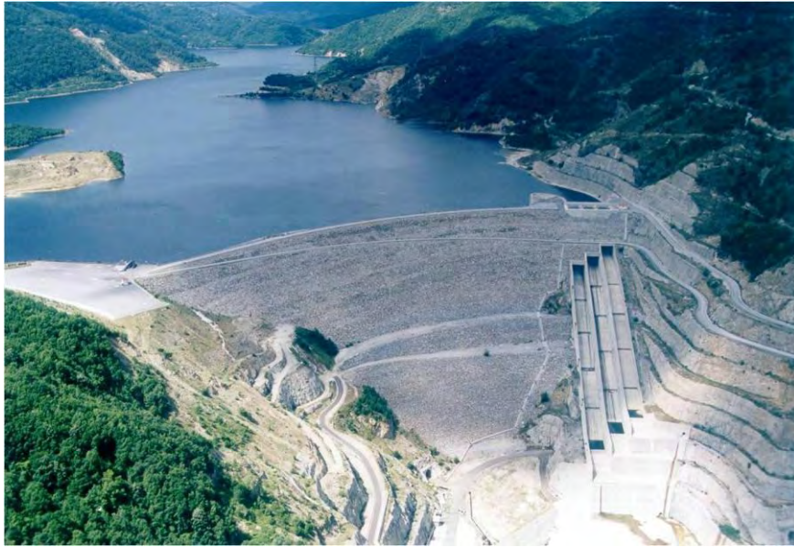
Εικόνα 1.5 Χομάτινο Φράγμα Θησαυρού, Δράμας [5].
