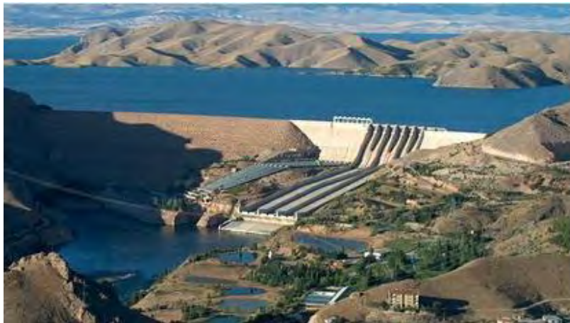
Εικόνα 1.6 Σύνθετο Φράγμα Keban, Τουρκία (Gravity & Rock dam) [6].
