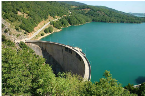
Εικόνα 1.3 Τοξωτό Φράγμα Πλαστήρα (Ταυρωπού) [3].
