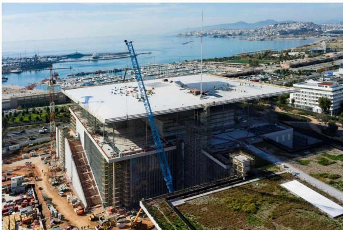
Εικόνα 19. Η οικοδόμηση του ΚΠΙΣΝ, (πηγή διαδίκτυο).
