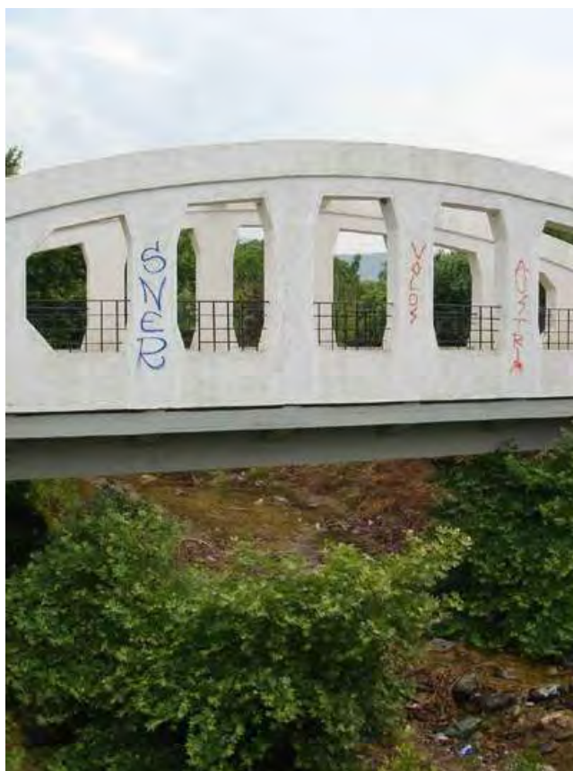
Εικ. 3: Η γέφυρα του Βρύχωνα, Πηγή : Σταμνάς
