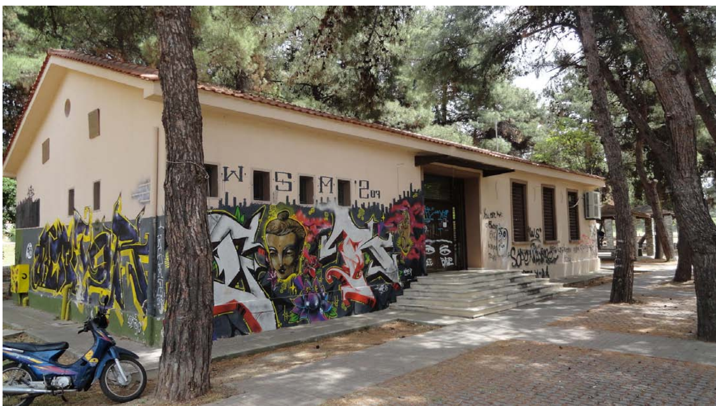
Εικόνα 28. Κτίριο στο συγκρότημα στο βορειοδυτικό άκρο
