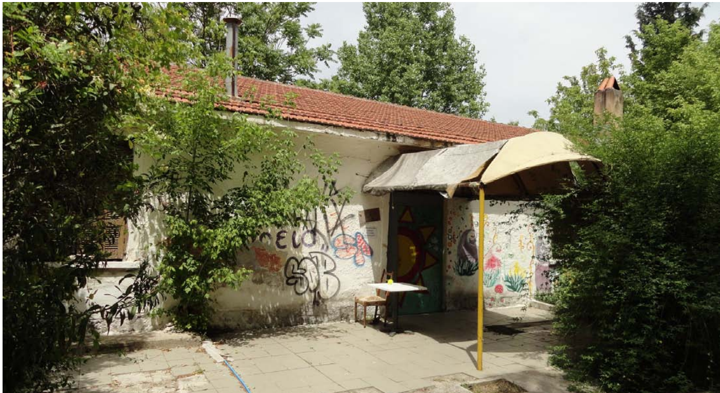
Εικόνα 27. Κτίριο στο συγκρότημα στο βορειοδυτικό άκρο
