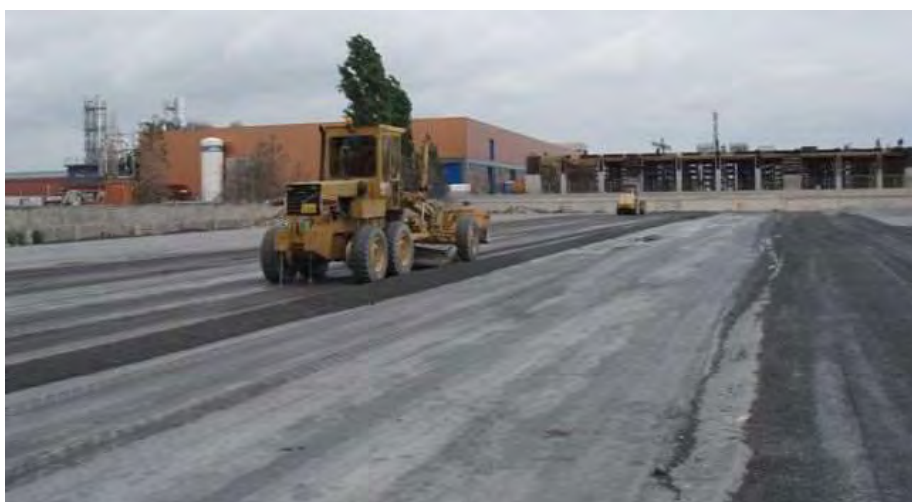
Εικόνα 2.2 Αδρανή οδοποιίας σε βιομηχανικές εγκαταστάσεις (Πηγή: www.aeiforos.gr )
