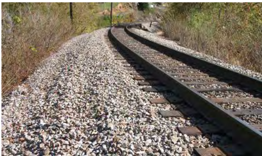
Εικόνα 2.1 Έρμα σιδηροδρομικών γραμμών (Πηγή: www.edillon.com )
