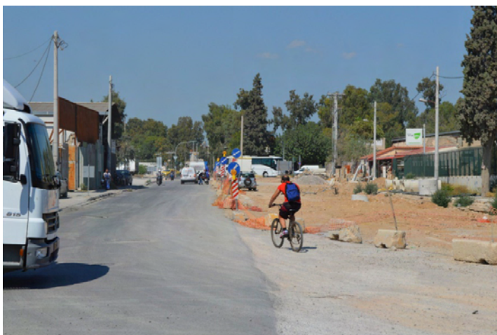
Εικόνα Β. 8.2.1. διαπλάτυνση της οδού Αγίας Άννας. Πηγή: Προσωπικό αρχείο
