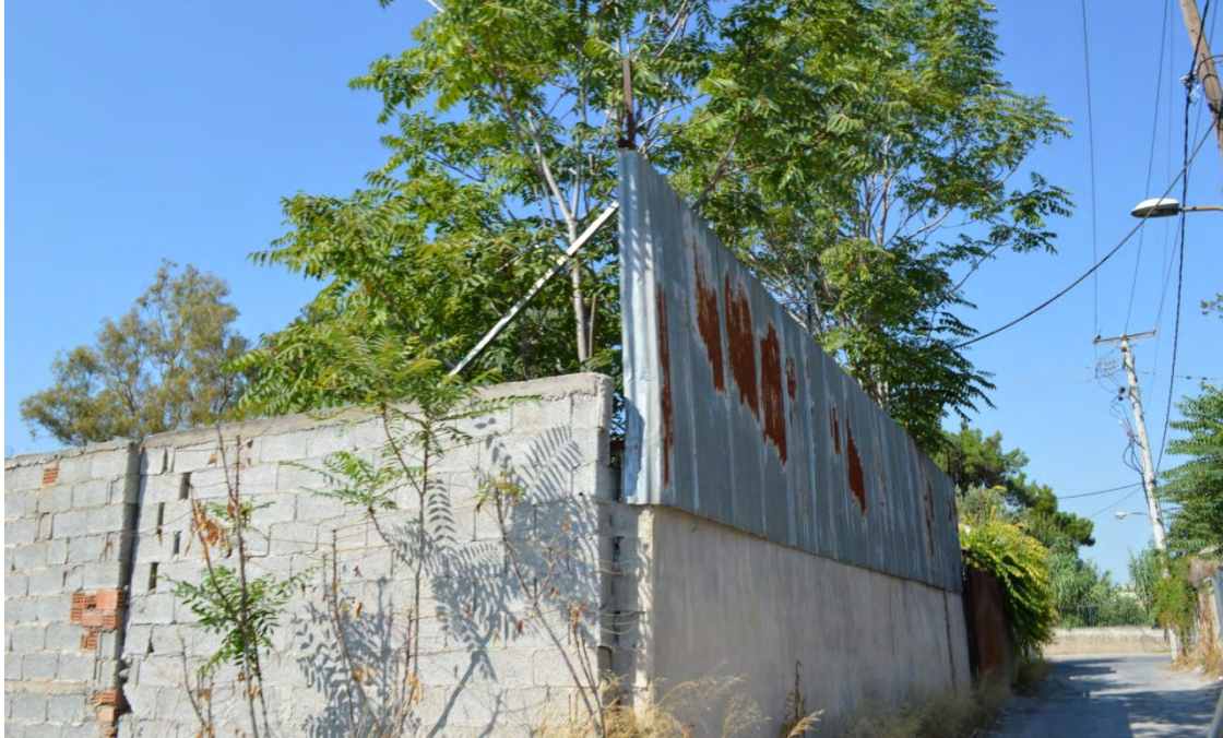
Εικόνα Β.8.2.4. Εσωτερικός φραγμός στον Ελαιώνα. Πηγή: Προσωπικό αρχείο.
