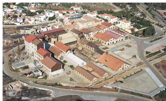
169 Εικόνα Γ.1.1.2. Το Τεχνολογικό και Πολιτιστικό πάρκο Λαυρίου, πηγή: Επίσημη ιστοσελίδα τεχνολογικού πάρκου: http://www.ltp.ntua.gr/home
