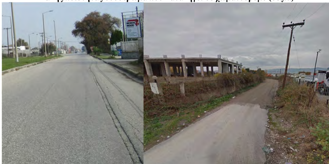
Εικόνα 1.3.6.2: Κατακερατισμένοι δρόμοι από την τοποθέτηση δικτύων (αριστερά) και κακής ποιότητας οδόστρωμα που καταλήγει σε χωματόδρομο (δεξιά)
