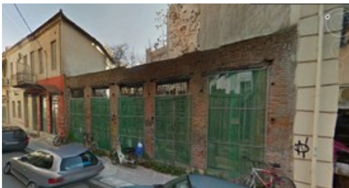
Εικόνες 31– 32. Ερειπωμένα κτίρια στο κέντρο της πόλης (Πηγή: google earth)
