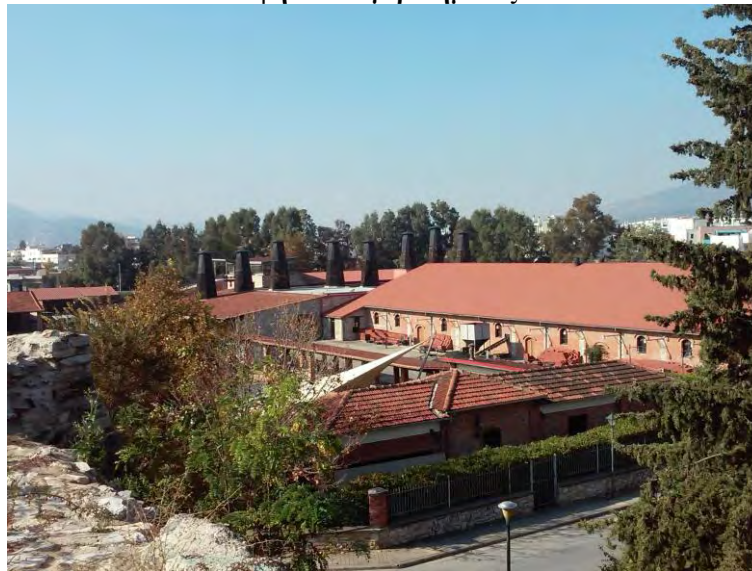
Εικόνα 4 30: Αποψη του συγκροτήματος Τσαλαπάτα
