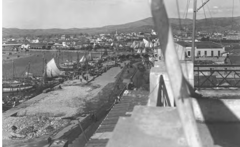
Εικόνα 3.4: Γενική άποψη του λιμανιού του Βόλου μετά τις επιχωματώσεις
