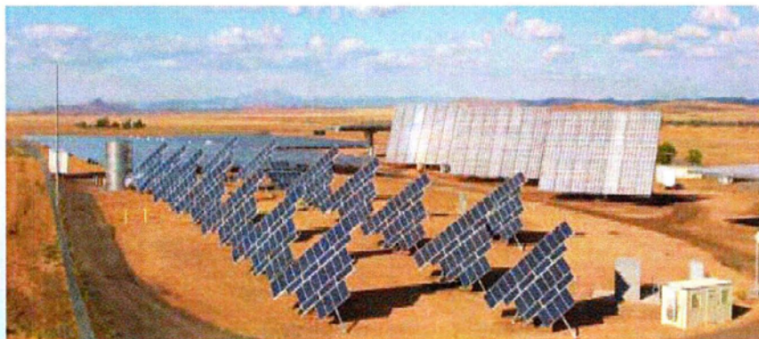
Εικόνα 2.21 : Φ/Β πάρκο με διάφορους τρόπους στήριξης
