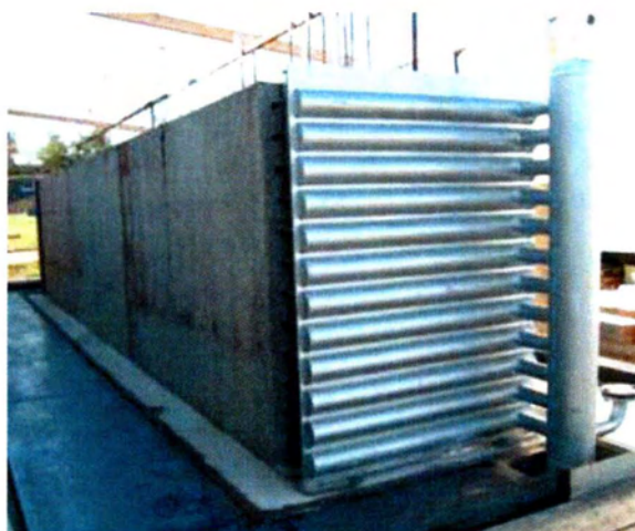
Εικόνα 30: Module Θερμικής Αποθήκευσης
