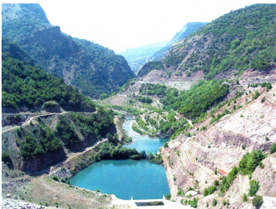
Εικόνα 4.6 : Υδροηλεκτρικός σταθμός Μεσοχώρας [27]
