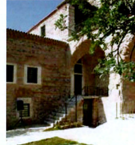
Εικόνα 4.11.: Κατοικία του Dimitrie Kantemir που μετατράπηκε σε μουσείο
