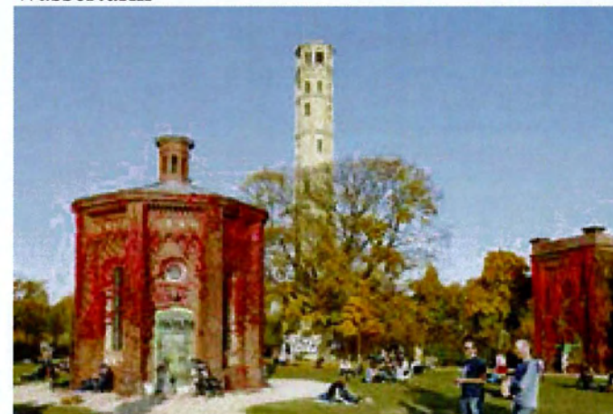
Εικόνα 4.16.: Ο πύργος του υδραγωγείου Wasserturm
