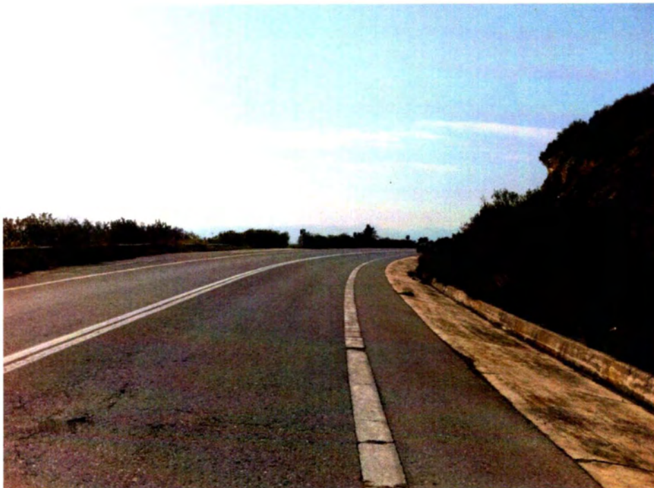
Φωτογραφία 23: Καμπύλη Κ22-κατεύθυνση προς Ν.Αγχιάλο
