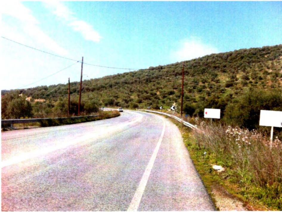
Φωτογραφία 14: Καμπύλη Κ13-κατεύθυνση προς Ν.Αγχιάλο
