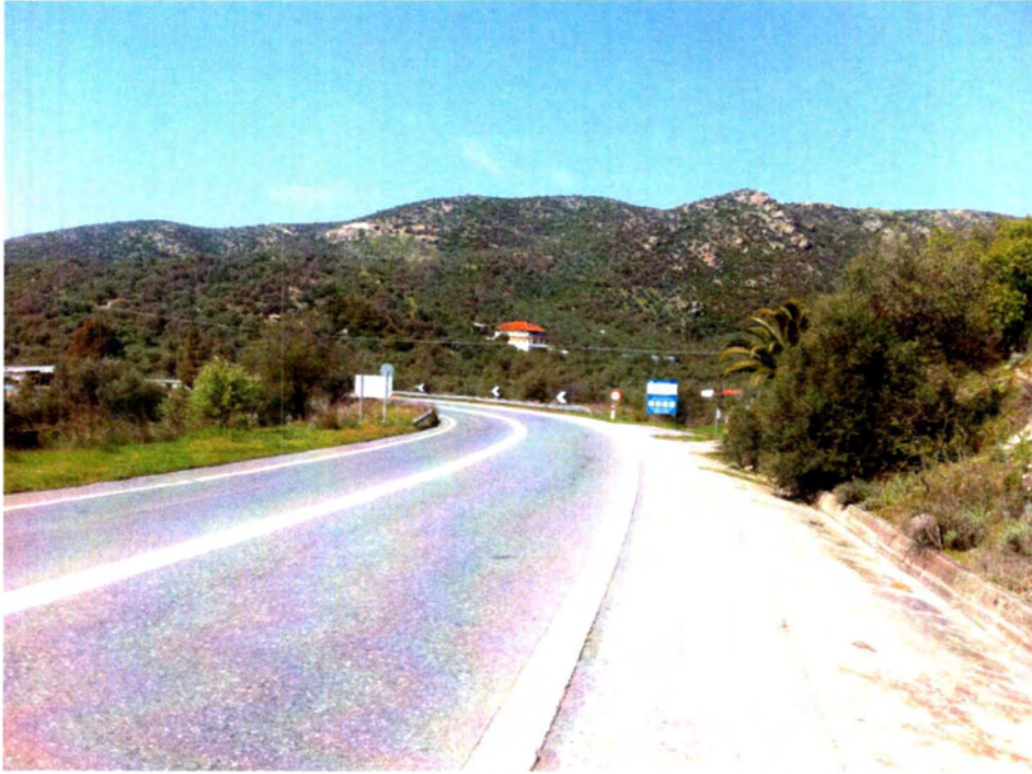
Φωτογραφία 20: Καμπύλη Κ19-κατεύθυνση προς Ν.Αγχιάλο
