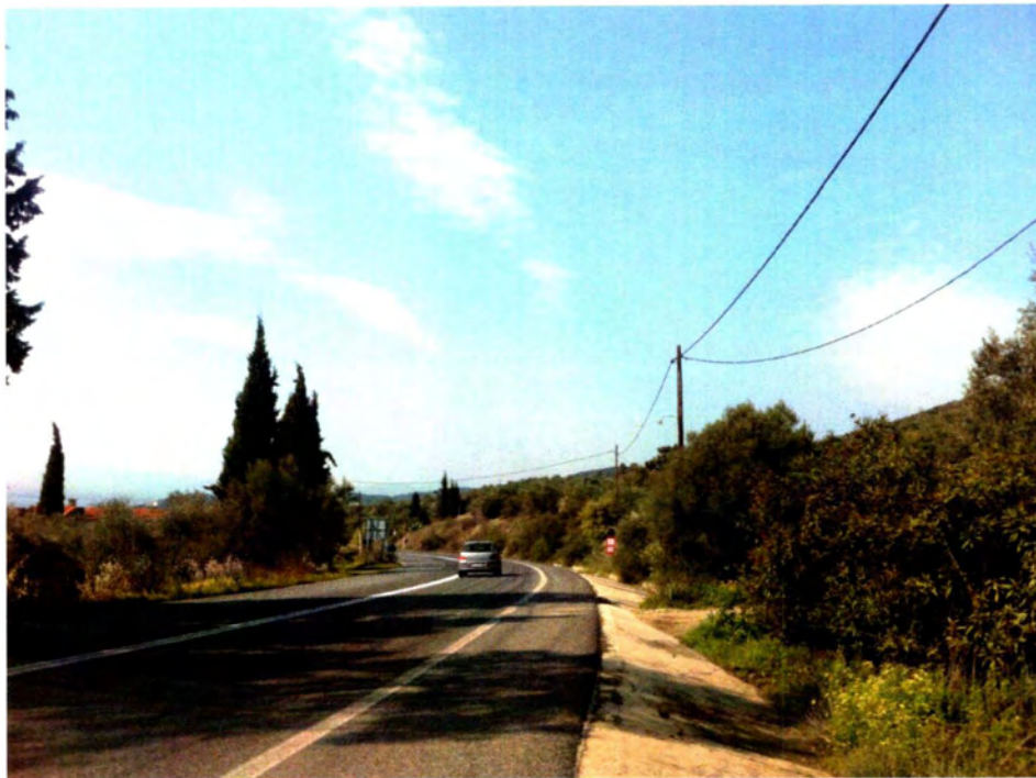
Φωτογραφία 11: Καμπύλη Κ10-κατεύθυνση προς Ν.Αγχιάλο
