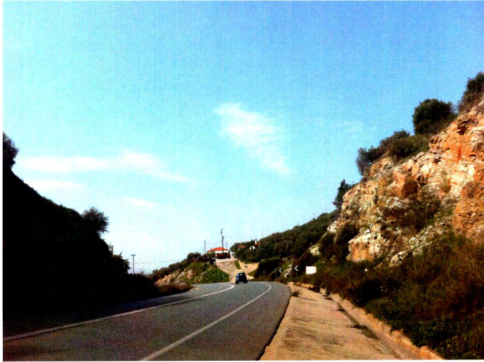
Φωτογραφία 7: Καμπύλη Κ6-κατεύθυνση προς Ν.Αγχιάλο
