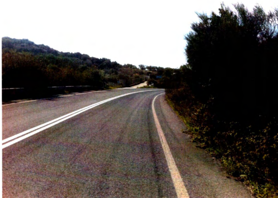
Φωτογραφία 19: Καμπύλη Κ18-κατεύθυνση προς Ν.Αγχιάλο
