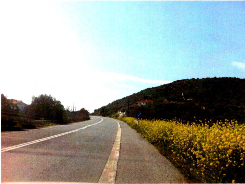
Φωτογραφία 22: Καμπύλη Κ21-κατεύθυνση προς Ν.Αγχιάλο
