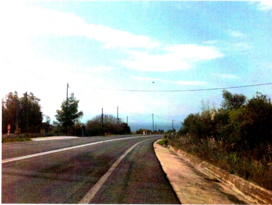
Φωτογραφία 12: Καμπύλη Κ11-κατεύθυνση προς Ν.Αγχιάλο
