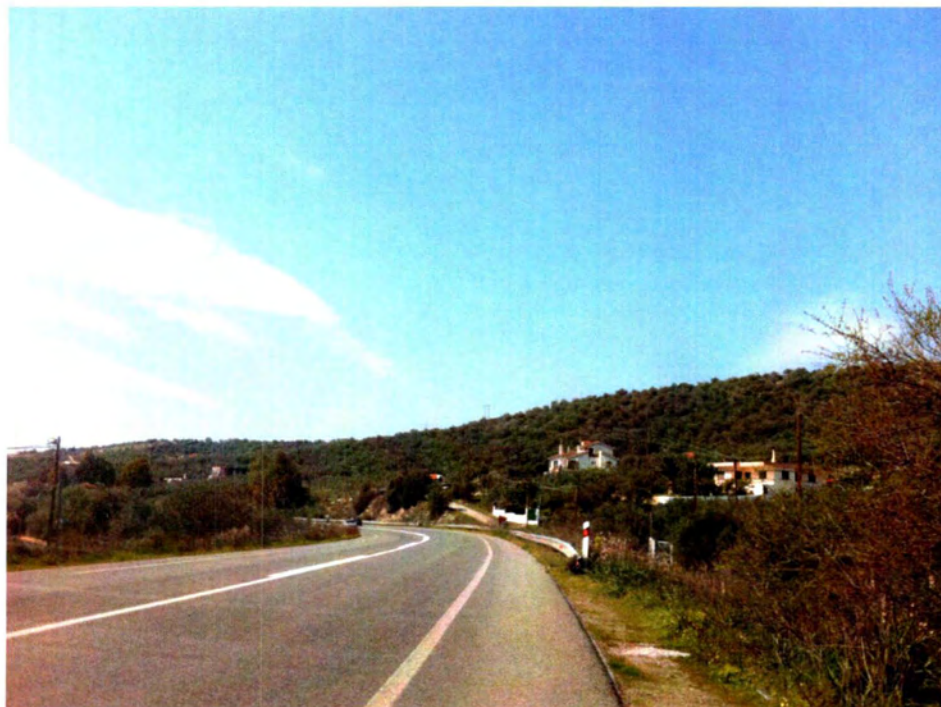
Φωτογραφία 16: Καμπύλη Κ15-κατεύθυνση προς Ν.Αγχιάλο
