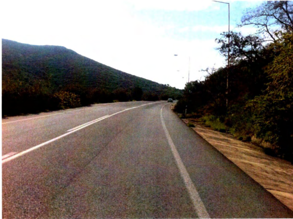
Φωτογραφία 3: Καμπύλη Κ2-κατεύθυνση προς Ν.Αγχιάλο
