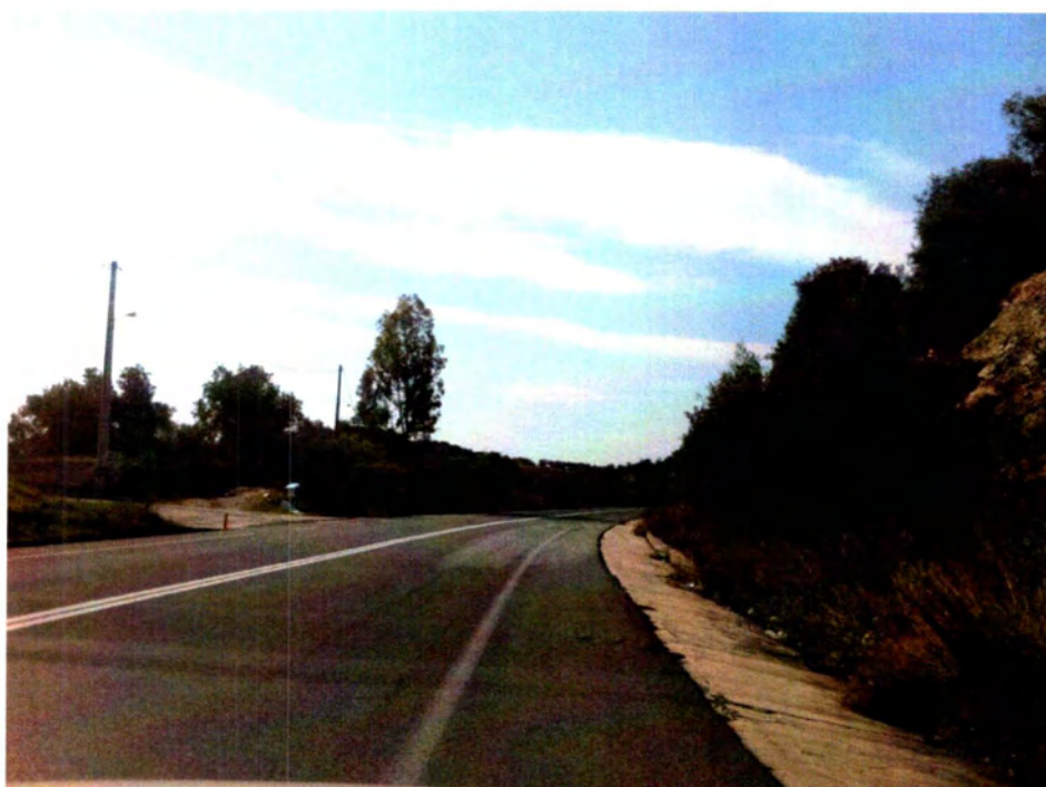
Φωτογραφία 17: Καμπύλη Κ16-κατεύθυνση προς Ν.Αγχιάλο
