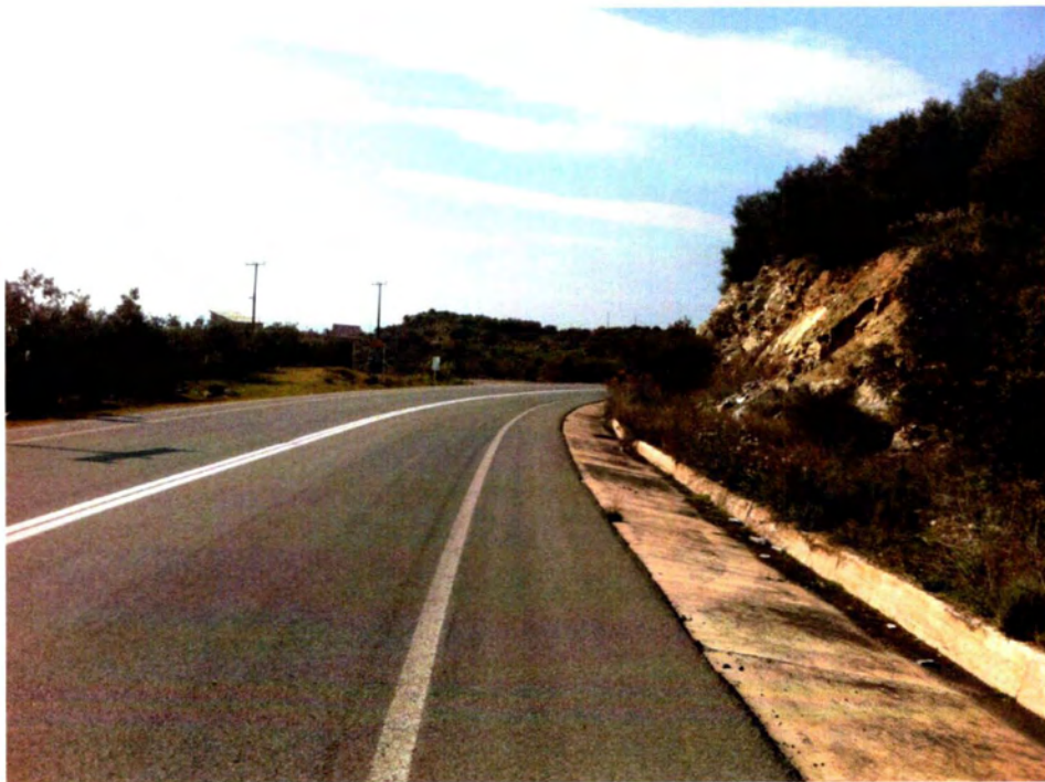
Φωτογραφία 15: Καμπύλη Κ14-κατεύθυνση προς Ν.Αγχιάλο
