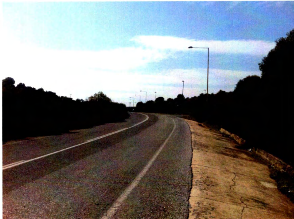
Φωτογραφία 4: Καμπύλη Κ3-κατεύθυνση προς Ν.Αγχιάλο
