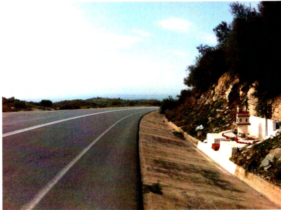
Φωτογραφία 8: Καμπύλη Κ7-κατεύθυνση προς Ν.Αγχιάλο
