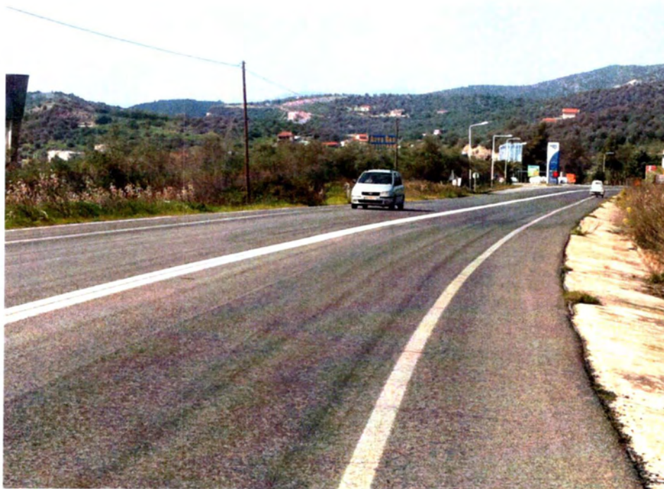
Φωτογραφία 13: Καμπύλη Κ12-κατεύθυνση προς Ν.Αγχιάλο
