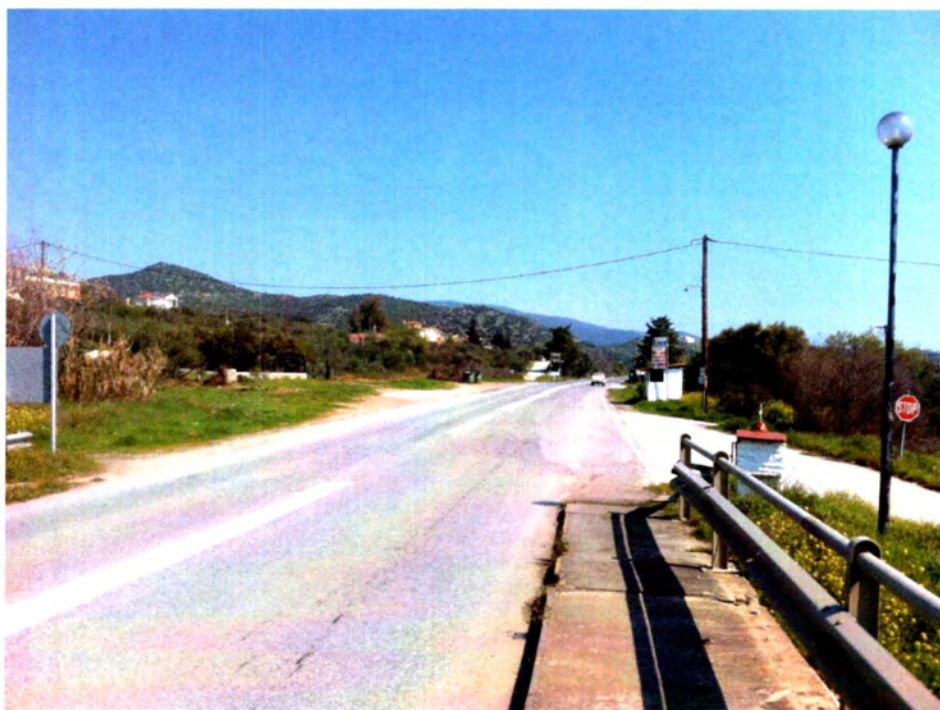
Φωτογραφία 28: Start point μετρήσεων-κατεύθυνση προς Βόλο
