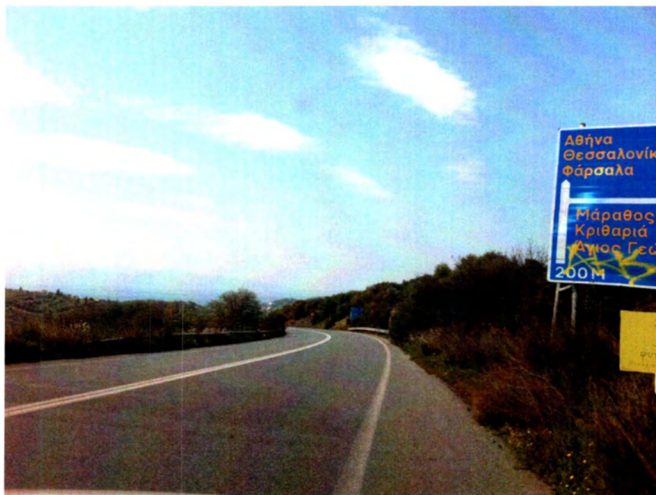
Φωτογραφία 9: Καμπύλη Κ8-κατεύθυνση προς Ν.Αγχιάλο
