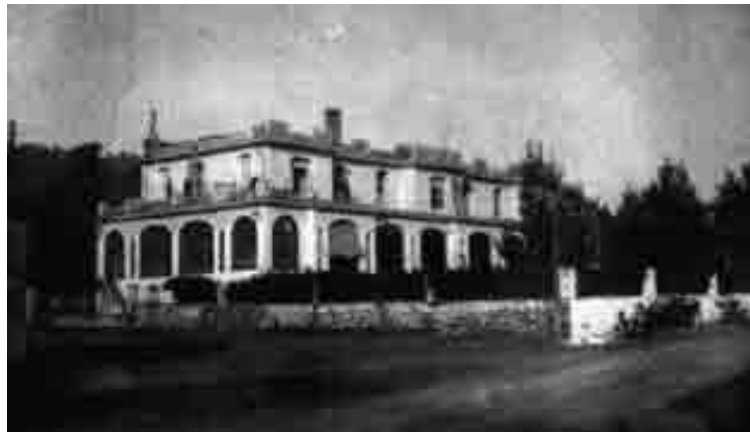
Εικόνα 54. Σανατόριο Αποστολίδη στον Διόνυσο της Πεντέλης.
