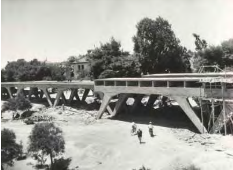
Εικόνα 39. Ο σταθμός του ηλεκτρικού σιδηρόδρομου υπό κατασκευή.
