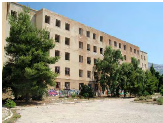
Εικόνα 61. Ματιές στις εγκαταλεημένες εγκαταστάσεις του Ν.Ι.Ε.Θ.
