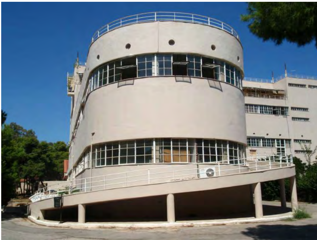
Εικόνα 32. Η χαρακτηριστική προέκταση του κτιρίου των Μαγειρείων-Πλυντηρίων (2010).
