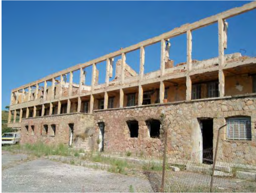
Εικόνα 66. Η πρόσοψη του Σανατορίου Δημοσίων Υπαλλήλων στην περιοχή Νταού Πεντέλης.
