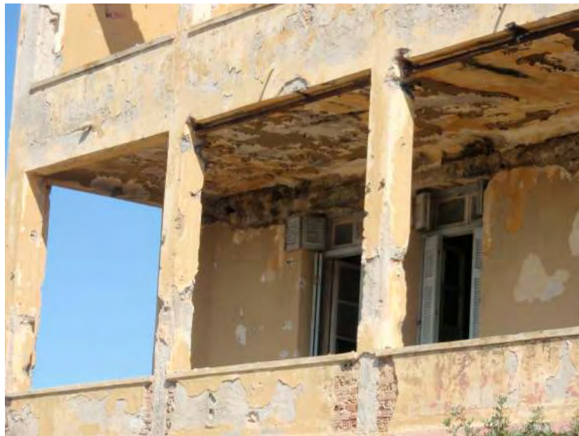
Εικόνα 69. Κοντινή λήψη στους εξώστες αεροθεραπείας. Τα ξύλινα παραθυρόφυλλα χωρίζονταν σε δύο άνισα μέρη, ώστε το άνοιγμα και το κλείσιμο τους να ρυθμίζει την εισερχόμενη ακτινοβολία. Τα μικρά παραθυρόφυλλα και τζάμια μπορούσαν να μείνουν ανοιχτά στη διάρκεια της νύχτας, ώστε να εισέρχεται καθαρός αέρας για τους νοσηλευόμενους φυματικούς και την ίδια στιγμή να περιορίζεται η ροή των ρευμάτων κρύου αέρα.
