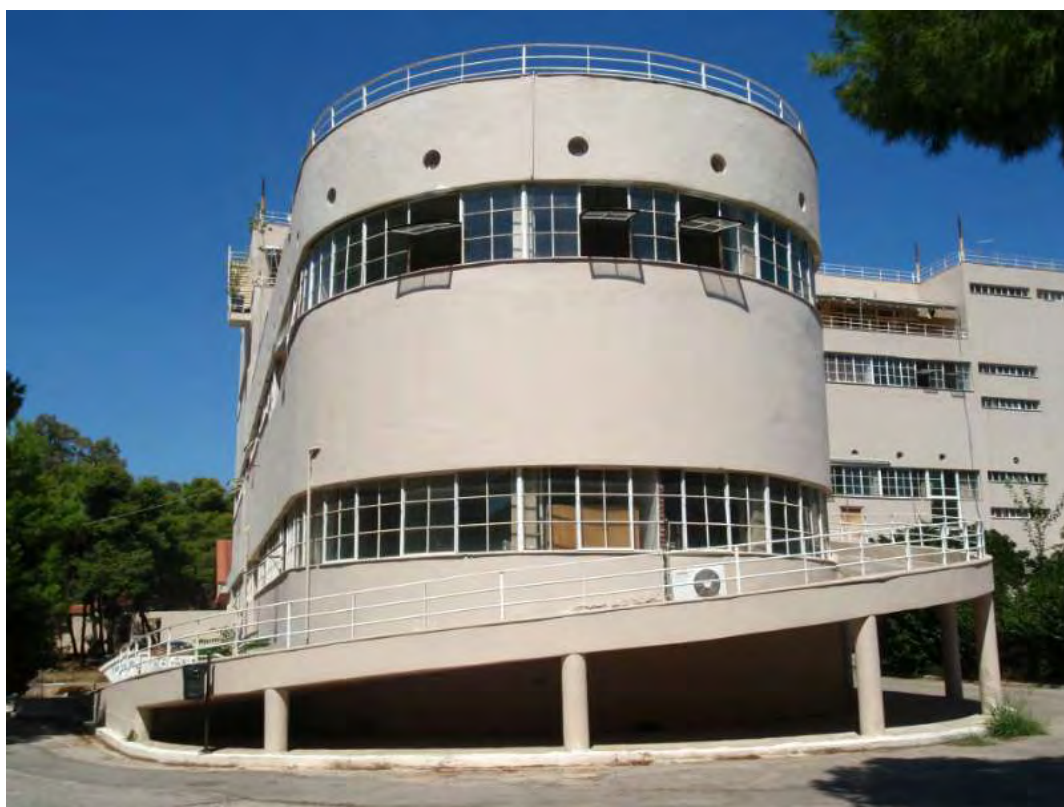
Εικόνα 32. Η χαρακτηριστική προέκταση του κτιρίου των Μαγειρείων-Πλυντηρίων (2010).
