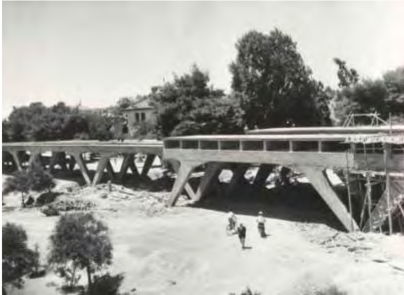
Εικόνα 39. Ο σταθμός του ηλεκτρικού σιδηρόδρομου υπό κατασκευή.
