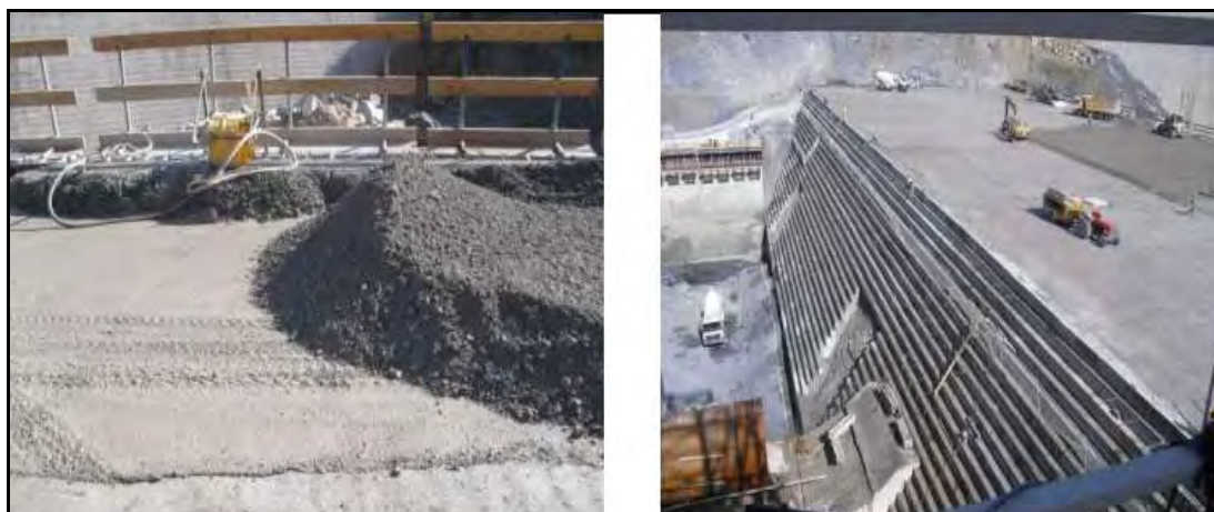
Σχήμα 2. 8 Τοποθέτηση και διάστρωση κυλινδρούμενου σκυροδέματος σε στρώσεις.
