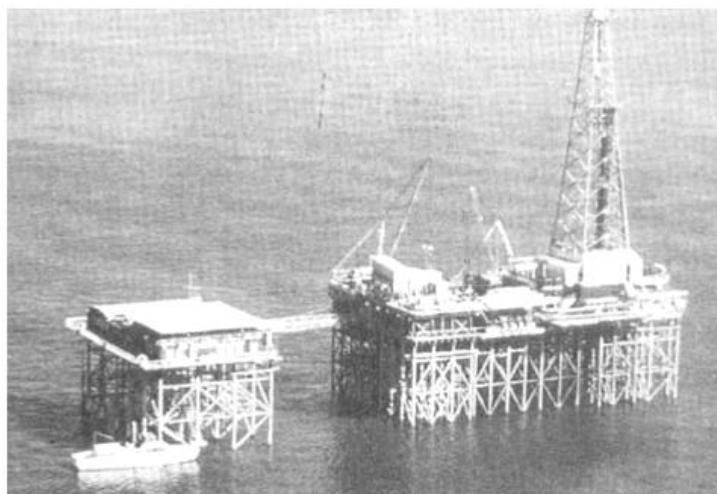
Σχήμα 1.1 Η πρώτη υπεράκτια εγκατάσταση πλατφόρμας στη Λουιζιάνα το 1947 [2].
