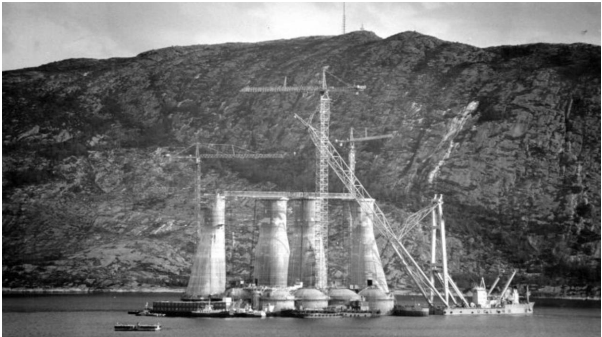
Εικόνα 3.1: Η πλατφόρμα εξόρυξης πετρελαίου Sleipner A GBS (Statoil, διαδίκτυο).
