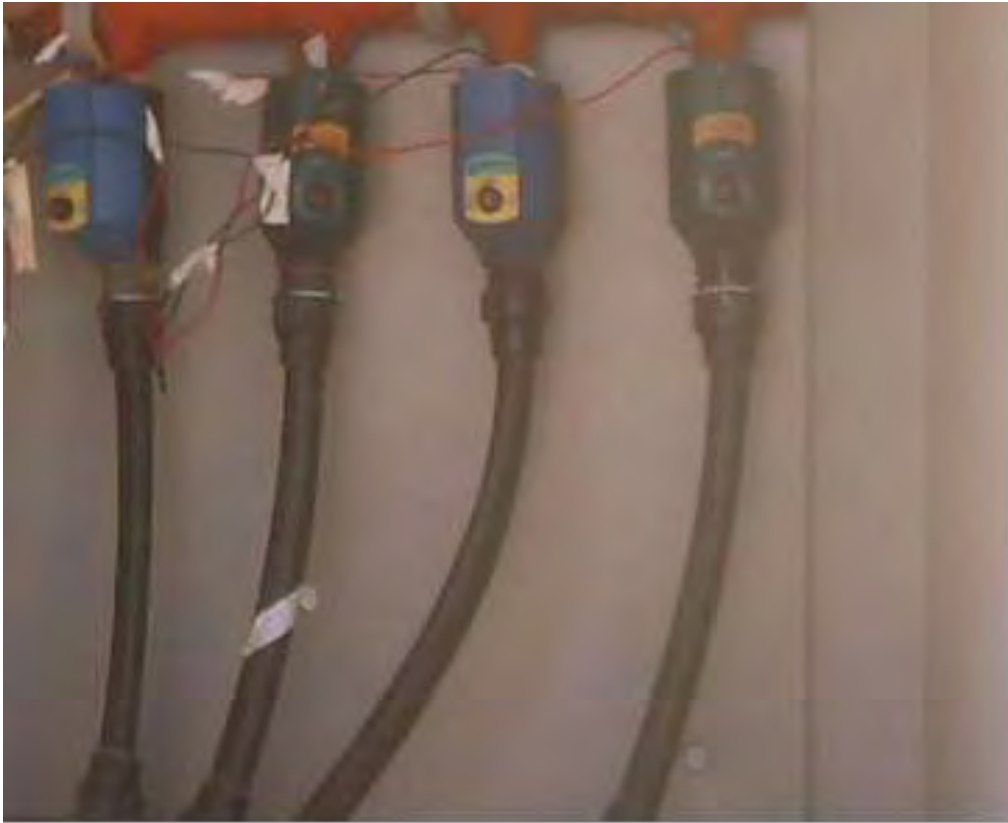
Εικόνα 5 : Ηλεκτροβάνες
