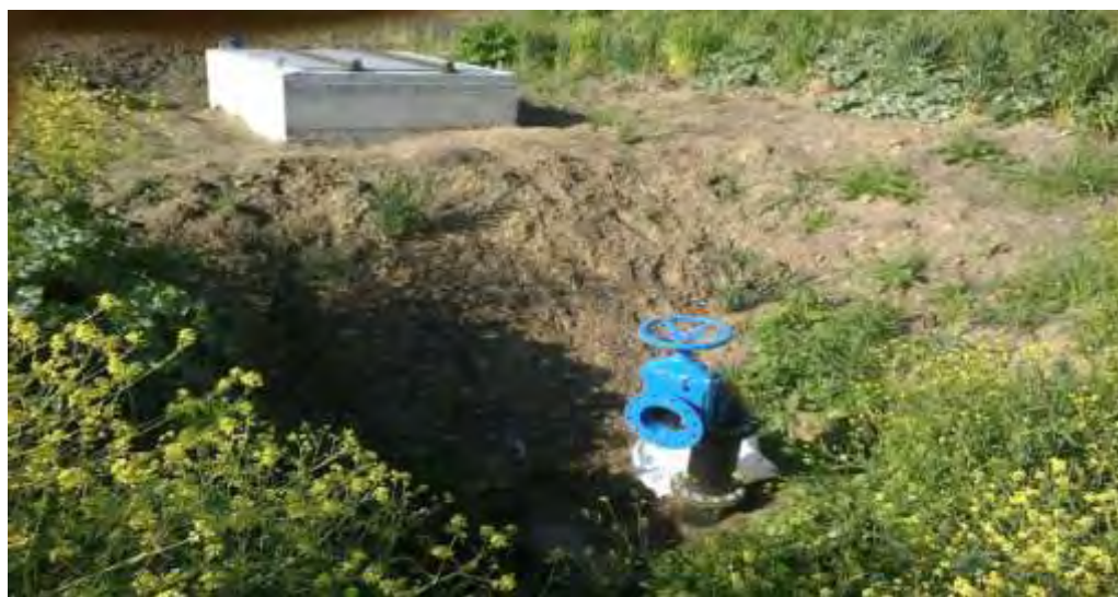
Εικόνα 4.13 βάνα ελεύθερης εκροής 2
