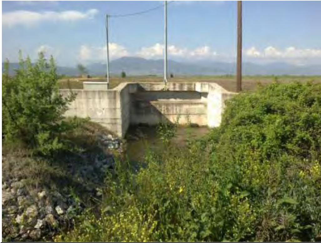
Εικόνα 4.3 εκφόρτιση ξηρορέματος
