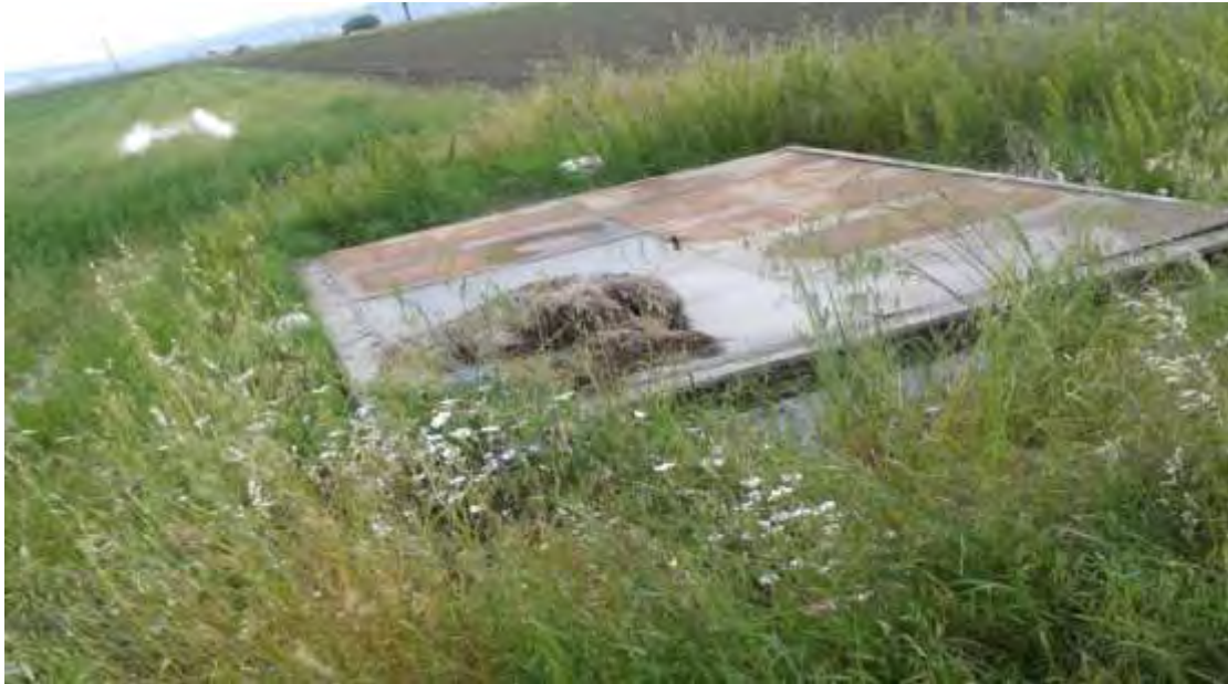
Εικόνα 5.20 βλαβη 8η διαρρηξη αγωγου φ1200 με τσιμεντένιο τοίχωμα στη ζώνη Σ3
