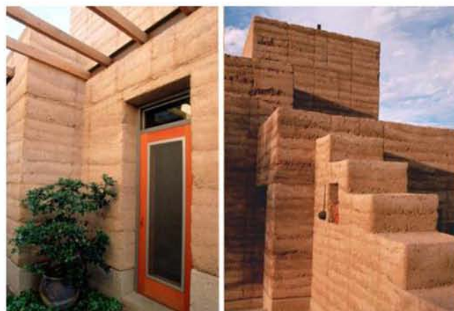
Εικόνα 56: Rammed Earth κατασκευή
