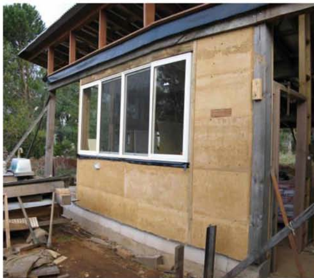
Εικόνα 59: Poured earth κατασκευή
