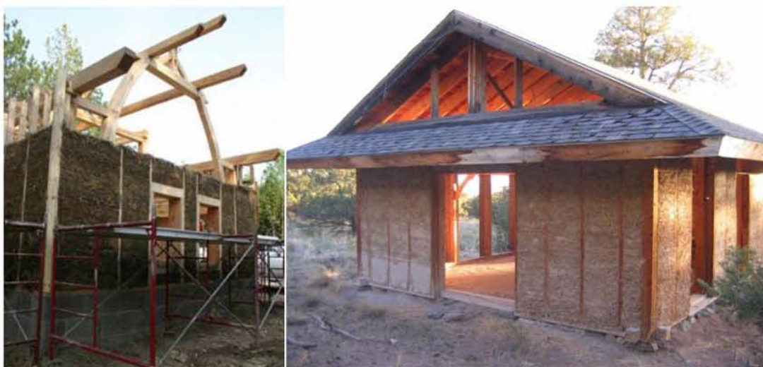
Εικόνα 57: Srawclay κατασκευές
