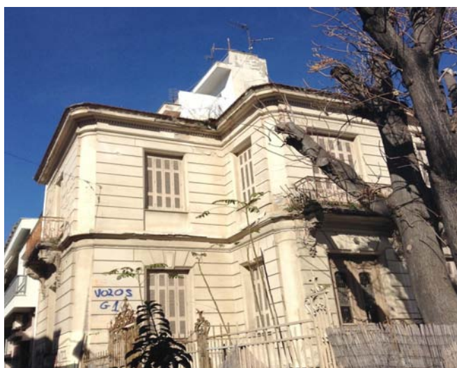
Εικόνα 4.2.: Υφιστάμενη κατάσταση οικίας Αδαμοπούλου
