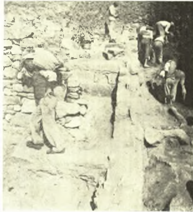
Εἰκ. 4. Ὁ τοῖχος Σ καὶ οἱ δύο ἐγκάρσιοι τοῖχοι Β καὶ Γ.
