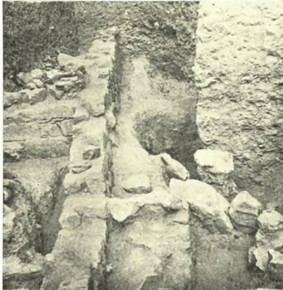
Εἰκ. 3. Ἀποψὶς τῶν ἐρειπίων. Ὁ μέγας ἀνατολικὸς τοῖχος Σ καὶ οἱ ἐγκάρσιοι τοῖχοι Β καὶ Γ.
