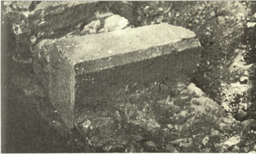
Εἰκ. 9. Τὸ πρὸς Ν τμήμα τῆς Δ πλευρᾶς τῆς ἐκκλησίας, ἐν ᾧ ἐντετειχισμένον τμήμα σπονδύλου κίονος.
