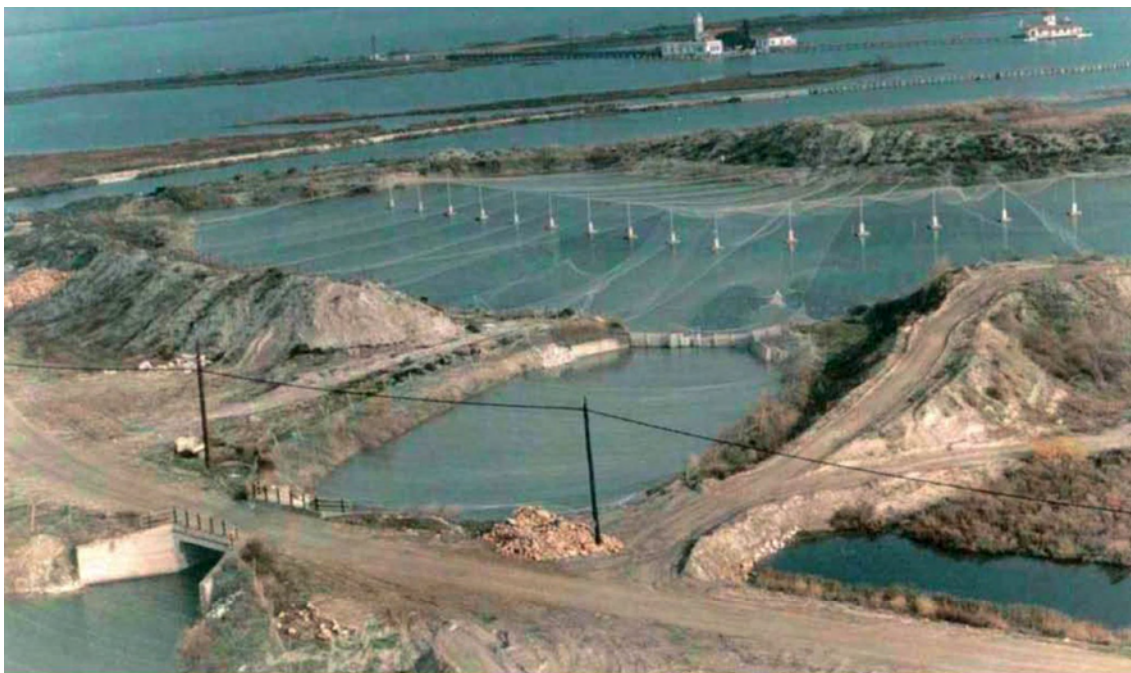
Εικόνα 6 - Αντιπαγετική προστασία και θέρμανση λιμνών ιχθυοκαλλιέργειας στο Πόρτο Λάγος, Ν. Ξάνθης
