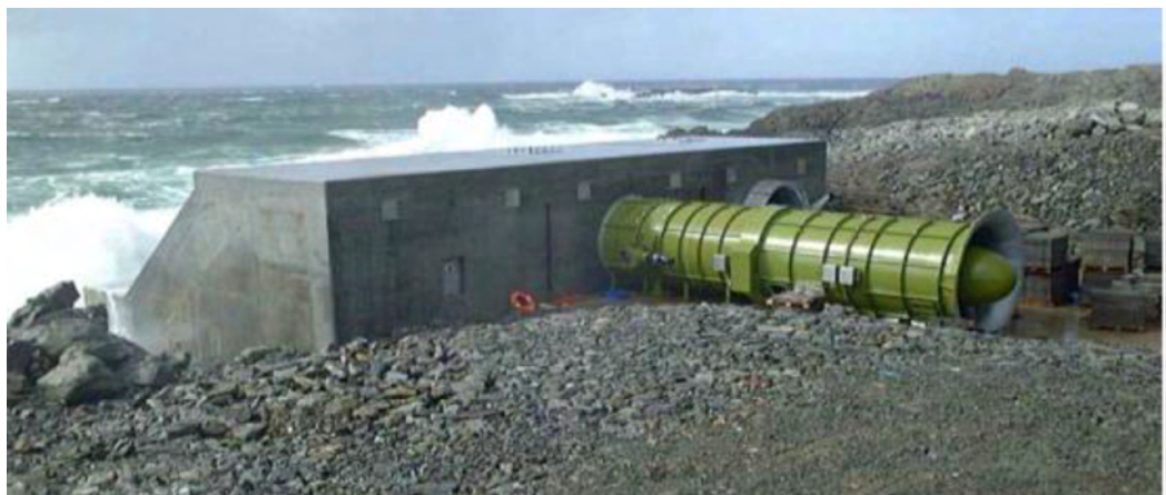
Εικόνα 1 - Απεικόνιση συστήματος εκμετάλευσης κυματικής ενέργειας στη νήσο του Islay στα δυτικά παράλια της Σκωτίας.
