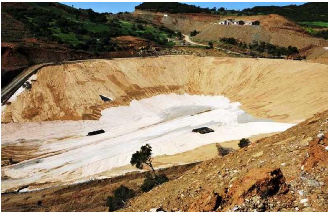
Εικόνα 2 : ΧΥΤΑ Φλόκα στο Νομό Αχαΐας Πηγή : www.patratona.gr
