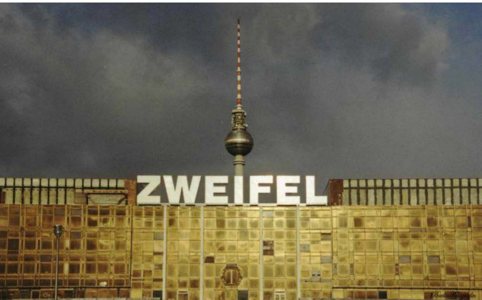
Εικ.iv: «Αμφιβολία» πριν την κατεδάφιση. Palast der Republik: «Palast des Zweifels», 2005.
