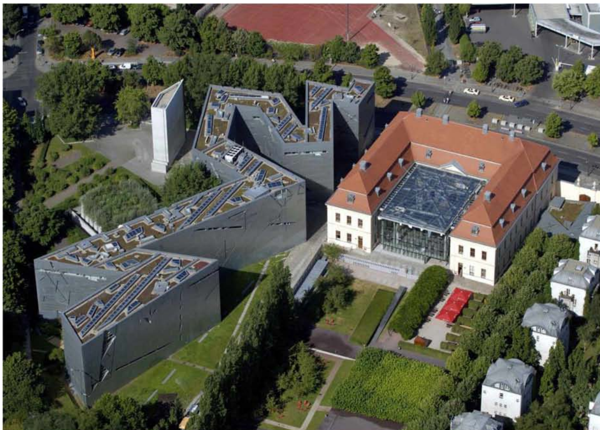
Εικ.4.27: «Μεταξύ των Γραμμών»: Το Εβραϊκό Μουσείο από ψηλά. Διακρίνεται, από τα ανοίγματα της οροφής, η ευθεία διακοπτόμενη γραμμή των κατακόρυφων κενών χώρων του κτιρίου.
