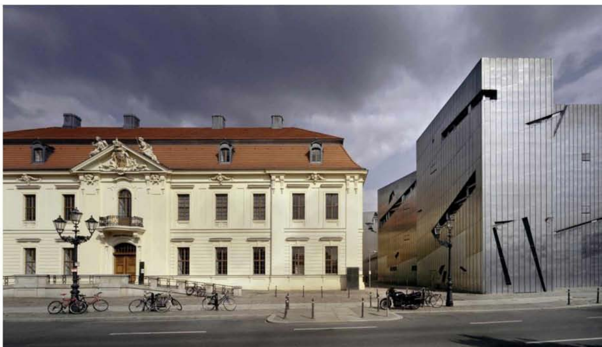
Εικ.4.28: Άποψη του Εβραϊκού Μουσείου και του Kollegienhaus από την πλευρά της Lindenstraße.
