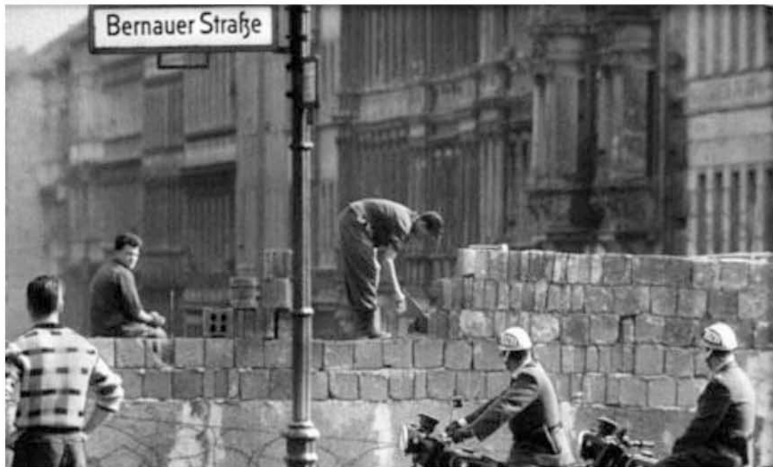
Εικ.4.8: Η κατασκευή του τείχους. Bernauer Straße, 1961.
