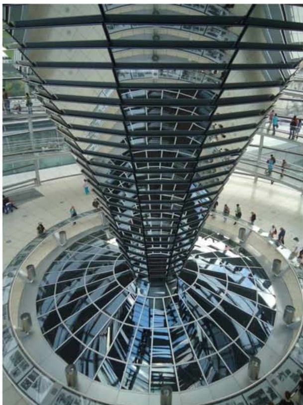
Εικ.4.37, 4.38: Στο εσωτερικό του θόλου. Η κατασκευή με τα κάτοπτρα εξυπηρετεί τις ενεργειακές ανάγκες, ενώ η ράμπα ανόδου μεταφέρει τους επισκέπτες στο ανώτατο σημείο - παρατηρητήριο.
