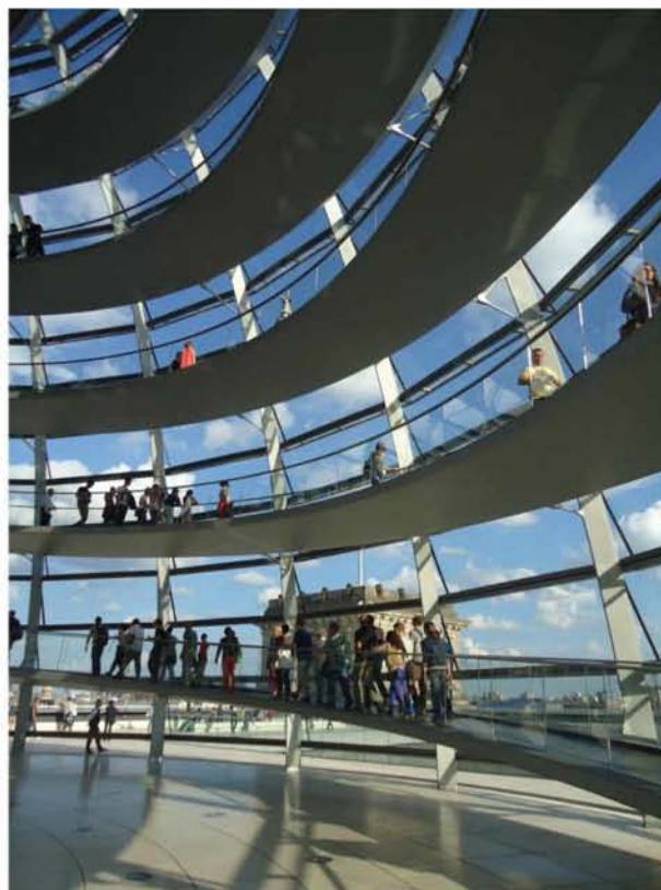
Εικ.4.37, 4.38: Στο εσωτερικό του θόλου. Η κατασκευή με τα κάτοπτρα εξυπηρετεί τις ενεργειακές ανάγκες, ενώ η ράμπα ανόδου μεταφέρει τους επισκέπτες στο ανώτατο σημείο - παρατηρητήριο.
