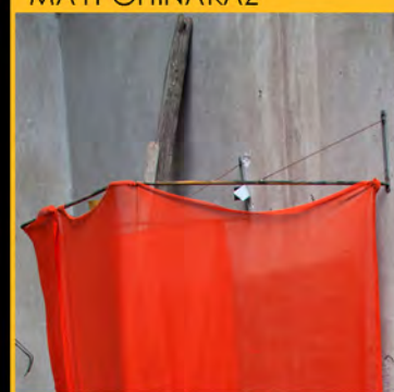
ΜΕΤΑΛΙΚΗ ΚΑΤΑΣΚΕΥΗ "Π"
