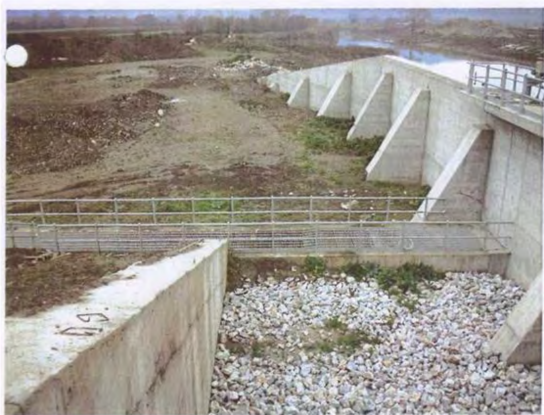
ΦΩΤ.11 ΑΠΟΨΗ ΔΙΟΔΟΥ ΙΧΘΥΩΝ (ΚΑΤΑΝΤΗ ΤΜΗΜΑ)
