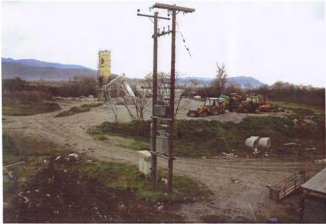
ΦΩΤ.1 ΑΠΟΨΗ ΕΡΓΟΤΑΞΙΟΥ
