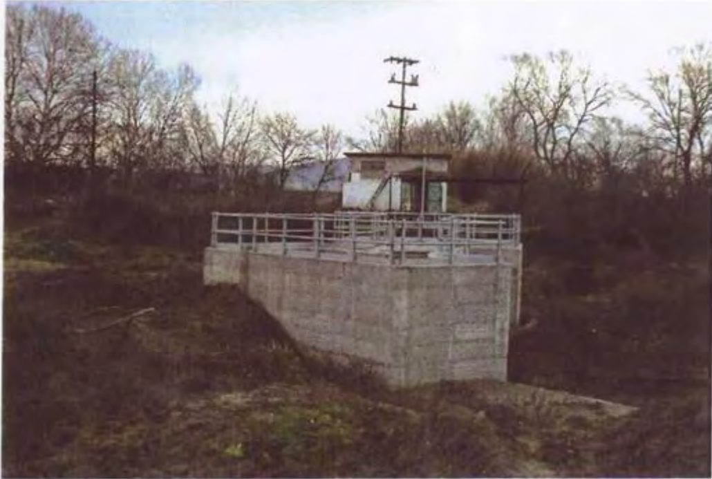
ΦΩΤΟ 15. ΑΠΟΛΗΞΗ ΥΔΡΟΛΗΨΙΑΣ ΚΑΙ Α/Σ Δ ΤΟΕΒ ΘΕΣΗ ΚΑΤΑΣΚΕΥΗΣ ΑΣ ΑΡΔΕΥΣΗΣ
