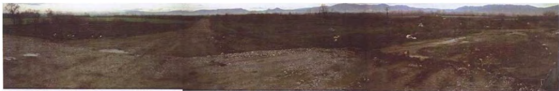
ΦΩΤ. 12 ΑΠΟΨΗ ΔΥΤΙΚΑ ΤΟΥ ΡΟΥΦΡΑΚΤΗ - ΠΡΟΣΩΡΙΝΗ ΑΠΟΘΕΣΗ ΥΛΙΚΩΝ ΓΙΑ ΕΠΙΧΩΣΗ ΠΑΛΑΙΑΣ ΚΟΙΤΗΣ- ΠΕΡΙΟΧΗ ΑΡΔΕΥΤΙΚΟΥ ΔΙΚΤΥΟΥ
