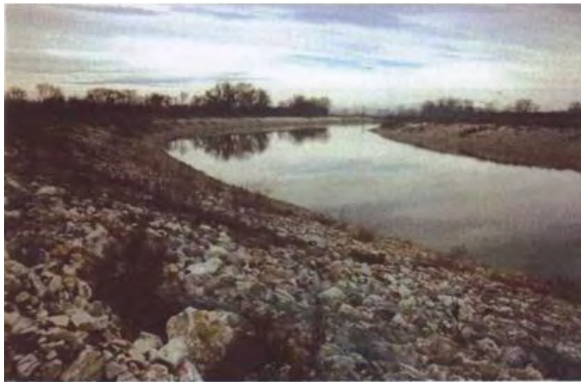
ΦΩΤ.8 ΑΠΟΨΗ ΝΕΑΣ ΚΟΙΤΗΣ ΚΑΙ ΕΠΕΝΔΥΣΗ ΜΕ ΣΑΡΖΑΝΕΤΙ
