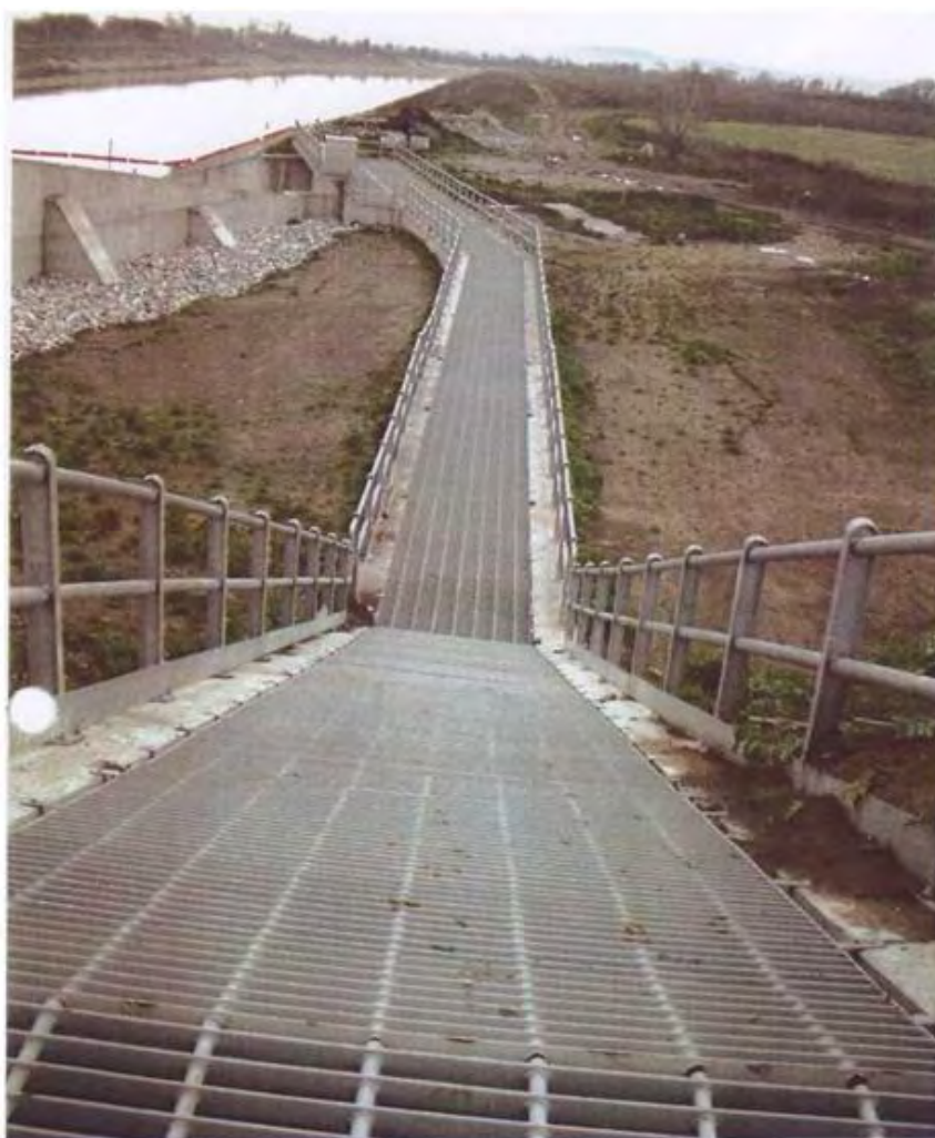
ΦΩΤ.10 ΑΠΟΨΗ ΔΙΟΔΟΥ ΙΧΘΥΩΝ (ΑΝΑΝΤΗ ΤΜΗΜΑ)
