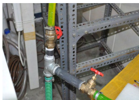
Εικόνα 3.9 Η διακλάδωση κύριου αγωγού (κάθετος) με By-pass (οριζόντιος).
