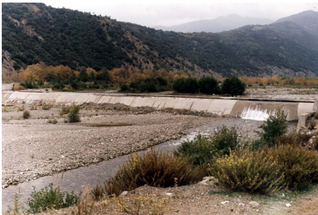
Εικόνα 2.2: Χαρακτηριστική άποψη του υπόγειου φράγματος, βάθους 15 m, το οποίο έχει κατασκευασθεί στα ανάντη της γέφυρας της οδού Υπάτης-Σπερχειάδας.
