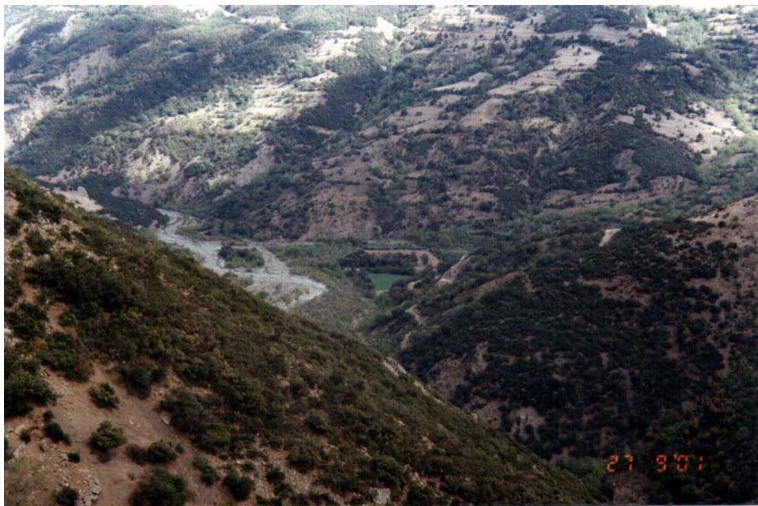
Εικόνα 2.1: Η θέση συμβολής των δύο υπολεκανών του χειμάρρου Ίναχου.
