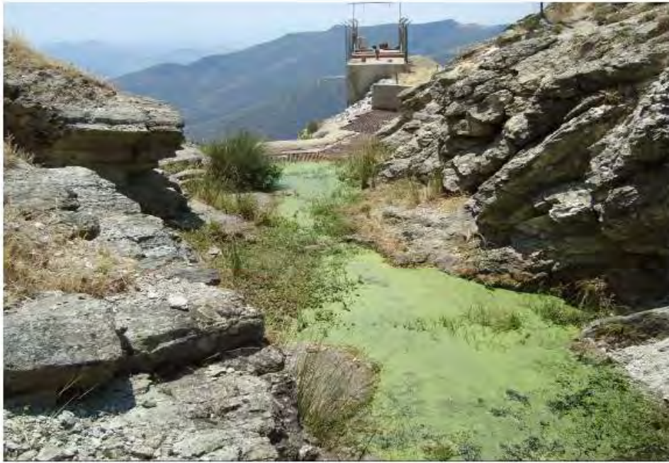
Εικόνα 7: Άποψη της υδροληψίας από τα ανάντη στο «ΥΗΣ Γόννοι 1» (πηγή: Βελώνης 2002).
