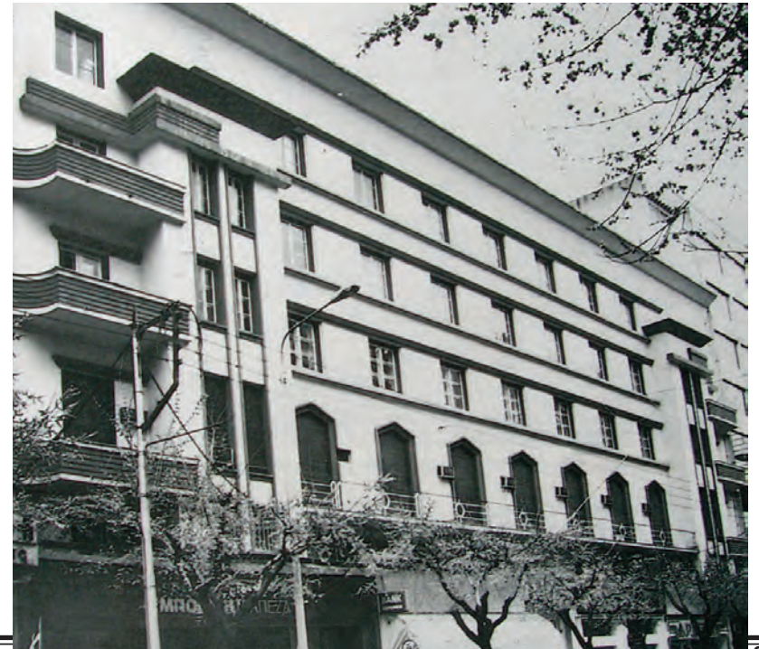
Η καπναποθήκη της Αυστροελληνικής εταιρείας καπνών επί της οδού Τσιμισκή πριν την αποκατάσταση.
