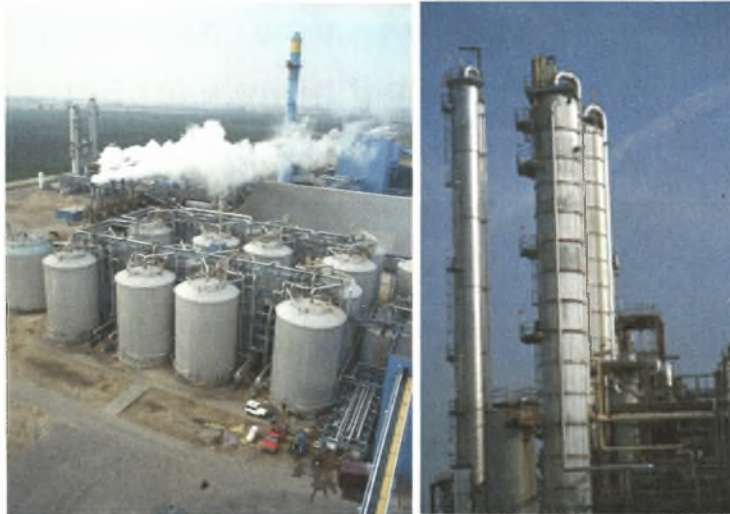
Φωτ. 10.4: Μονάδα παραγωγής βιοαιθανόλης. Δεξιά οι πύργοι απόσταξης ( www.nrel.gov )
