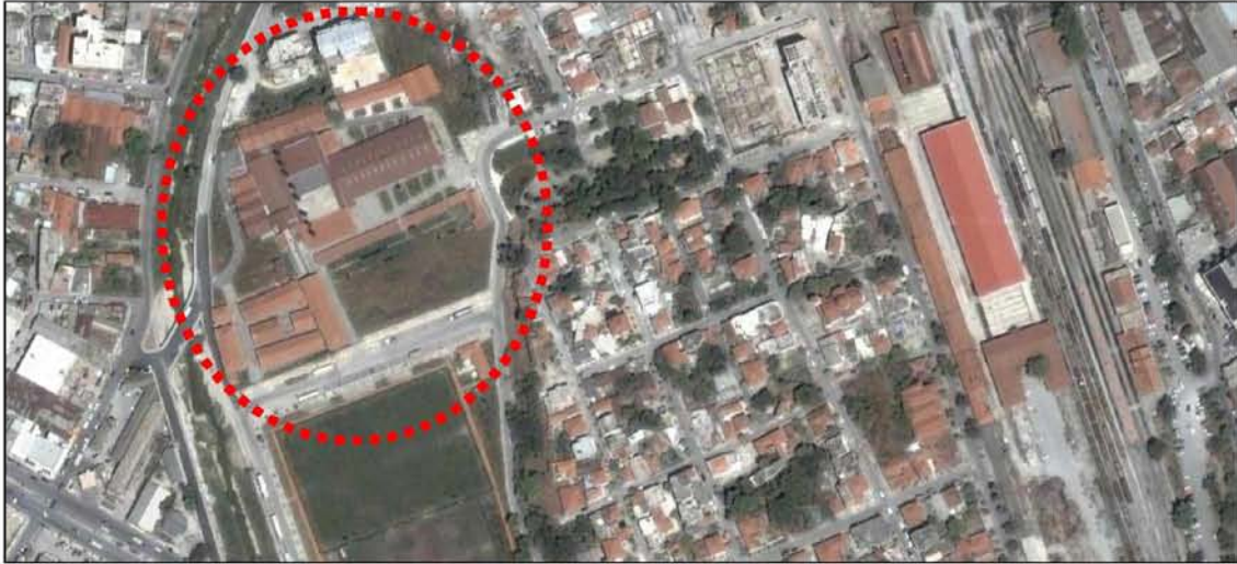
Εικ. 20. Το συγκρότημα στην περιοχή των Παλαιών από «ψηλά». Νότια σε άμεση γειτνίαση βρίσκεται το γήπεδο του Μαγνησιακού, δυτικά ο χείμαρρος Κραυσίδωνας και ανατολικά η περιοχή του «Κάστρου». (πηγή: http://maps.google.com/ , ίδια επεξεργασία)
